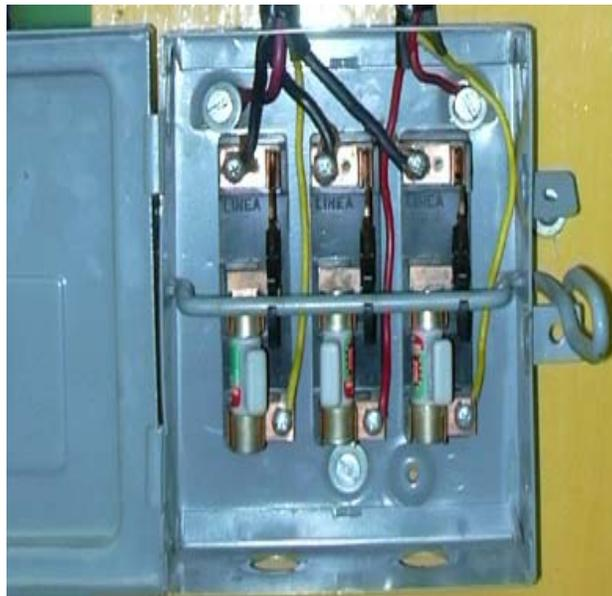
Fig.3.12 Interruptor de seguridad utilizado de la marca Federal Pacific Electric (FPE).
