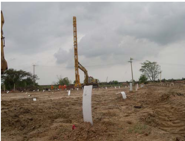
Figura No. 8.10 Drenes verticales prefabricados ya instalados. Al fondo se aprecia el equipo de construcción.
