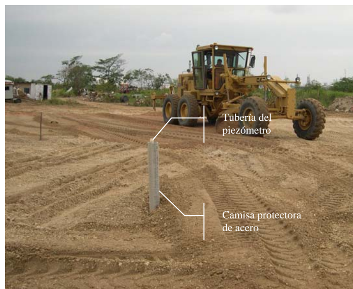
Figura No. 8.2 Arreglo de la protección de acero para la tubería vertical del piezómetro Al fondo se ve el equipo de construcción del terraplén.
