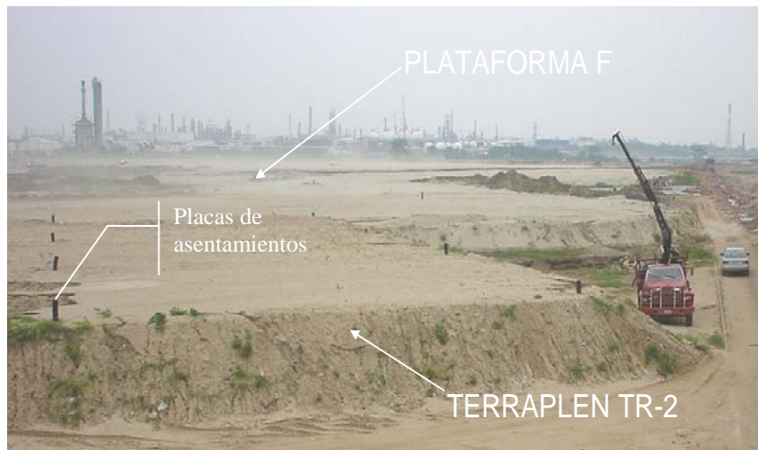
Figura No. 9.1. TR-2 totalmente construido. La “plataforma F” que se señala corresponde con los rellenos definitivos ubicados al norte-orienté del TR-2.
