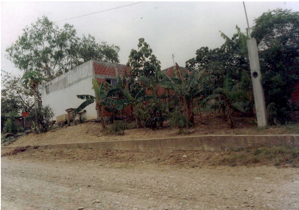
Vivienda con invasión en otro lote
