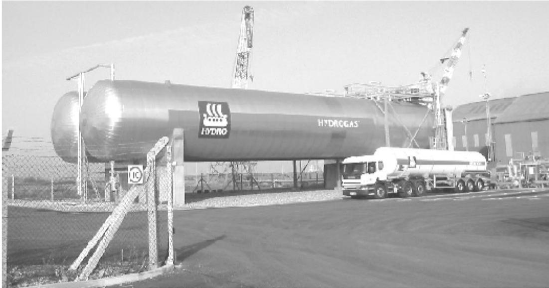
**Fig. 3.3.1.2 Tanques de almacenamiento de CO<sub>2</sub>**
