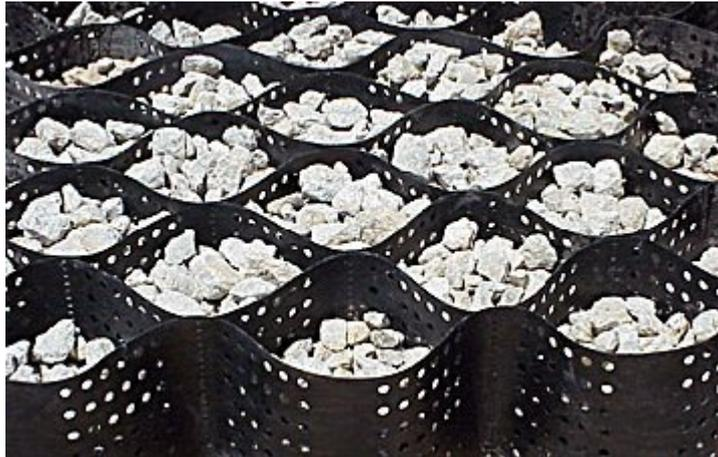
Preparación de geocelda para soporte de cargas.
