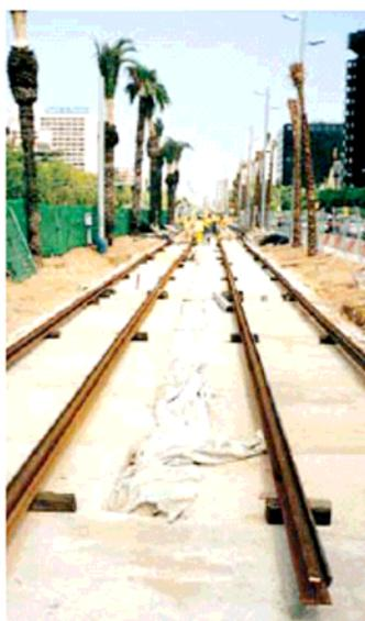
La grava se cubre con geotextil, mientras se construye el encofrado de plataforma de vía, Tranvía Denver, USA
