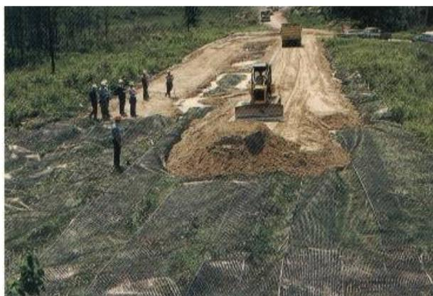
Ejemplo de utilización de geogrid, en la construcción de un camino
