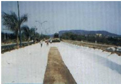
Carreteras, aplicación en una de las capas inferiores al pavimento.
