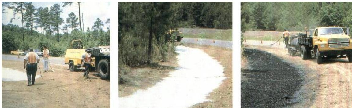
1. Aplicación de hilos sintéticos con aire. 2. Capa de hilos desordenada a la orilla del camino terminada. 3. Aplicación de asfalto encima de la capa desordenada de hilos.
