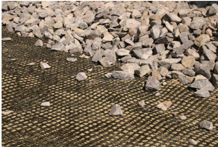
Ejemplo de fricción entre georred y capas del suelo.
