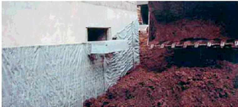
Geotextil actuando como elemento drenante, y protección de muros enterrados.
