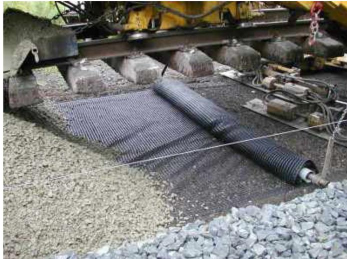
Fotografía de georred en el refuerzo de una vía ferrea, en Texas.
