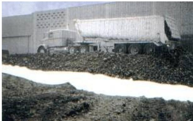
Geotextil colocado entresuelo de mala calidad y el suelo agregado, para establecer una frontera permeable que evite la incrustación y la contaminación del material selecto.
