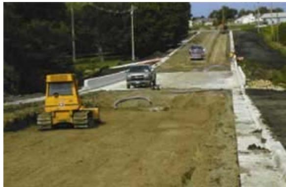
Geocompuesto triplanar utilizado como base en carretera, permitiendo tener una capa bien drenada y por lo tanto seca. Milán (Italia).
