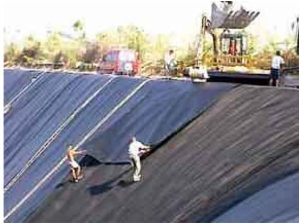
Geocompuestos usados en la recolección de lixiviados y sistemas de extracción en Calcinado (Italia).
