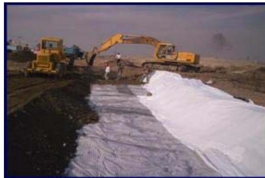
Geotextil como sistema de refuerzo en camino.
