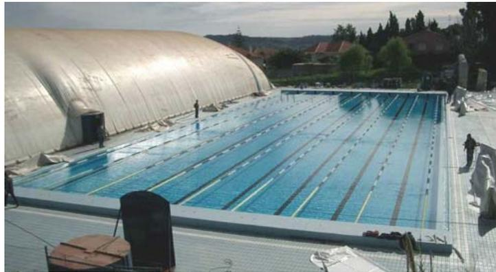
Rehabilitación de la piscina de la Universidad Politécnica de Valencia, instalando geotextil y geomembrana laminada.
