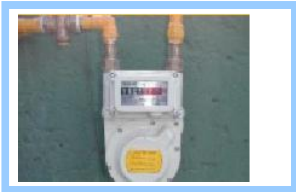
← Figura 14. Equipo empleado para registrar el consumo de gas natural en una casa habitación. (Cortesía de METROGAS, 2005)
