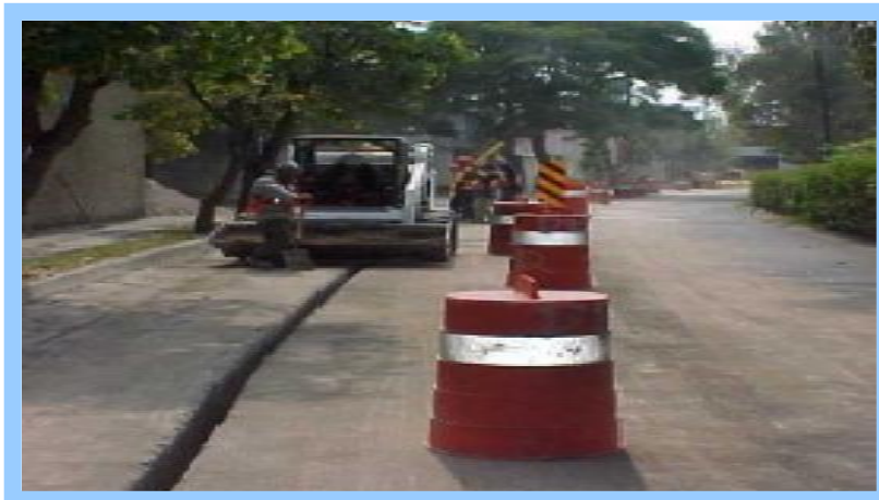
Figura 15. Excavación de la zanja para las tuberías de gas natural. (Cortesía de GNM [H] ).
