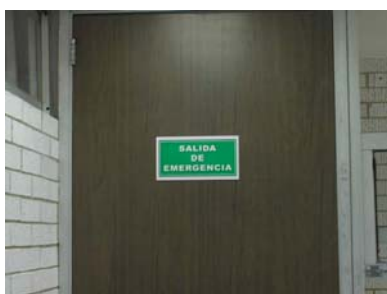
Fig. 19 Salida de emergencia
