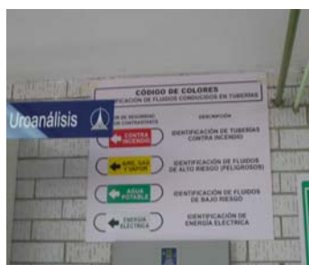
Fig. 20 Código de colores para identificación de tubería
