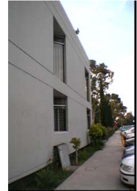
Muros de concreto armado acabado aparente
