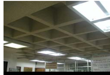
Losas reticular de concreto armado
