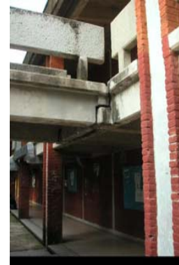
Columnas y traveses de concreto armado, muros de mampostería aparente
