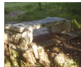
BANCA DE CONCRETO PARQUE JAPON
