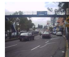
PUENTE PEATONAL CONTRAEZQUINA DEL PARQUE JAPON
