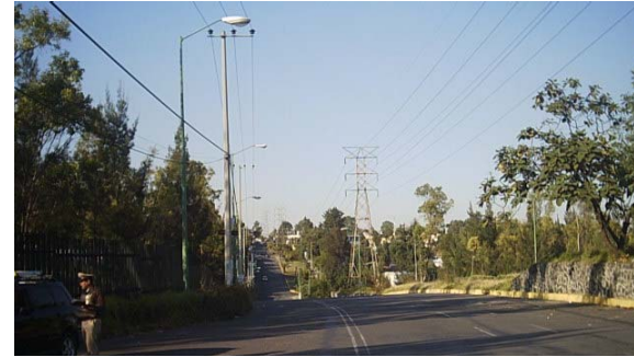
TORRES DE ALTA TENSION
