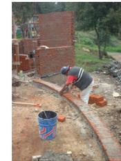
Armado de castillos en planta baja y continuación de impermeabilización de corona de zapatas corridas.
