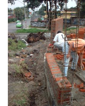
Impermeabilizado en la corona de la zapata para colocar tabiques de los muros de la planta baja.
