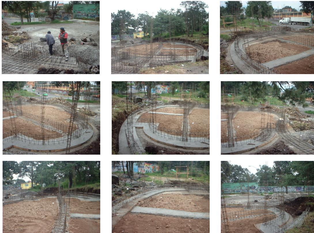
Elaboración del armado de la plantilla de cimentación y armado de zapatas corridas.
