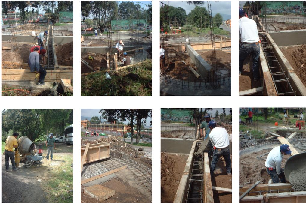
Cimbrado de la plantilla de cimentación y las zapatas, además del colado de las zapatas corridas.
