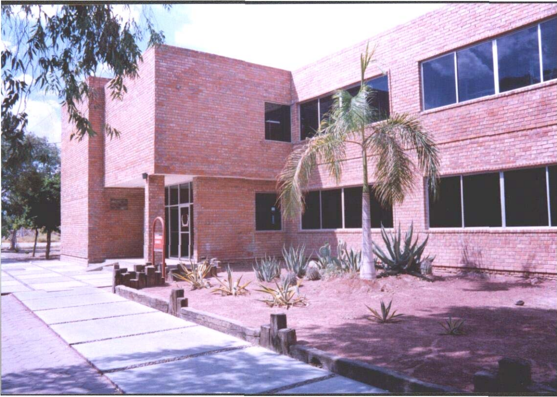
Zona de bocinas 1 b Edificio 2
