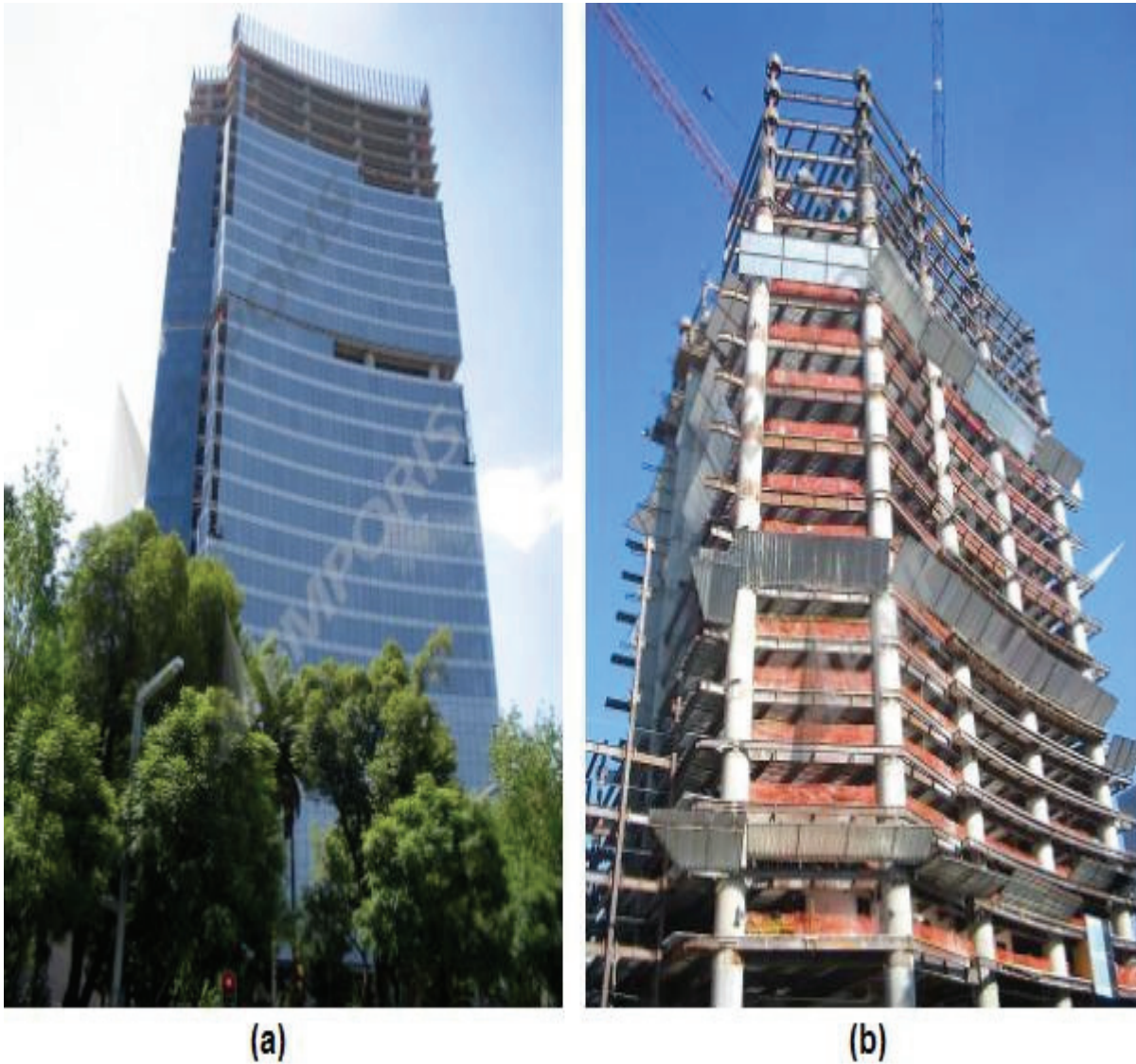
Figura IV.3. Fachada y estructura principal del inmueble.
