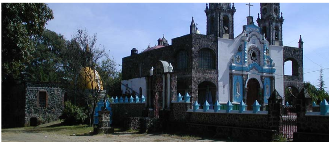
Iglesia de Jumiltepec, a la izquierda se observa la casa habitación del convento que se abastecerá del sistema de captación.
