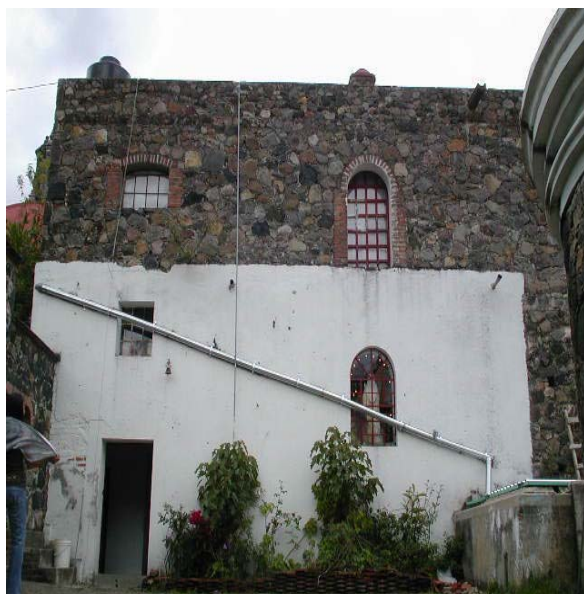
Tubería de lámina galvanizada de 4"Ø que conduce el agua del techo al filtro de arena y grava.
