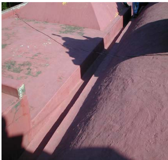
Techo de la Iglesia, que capta el agua de lluvia.
