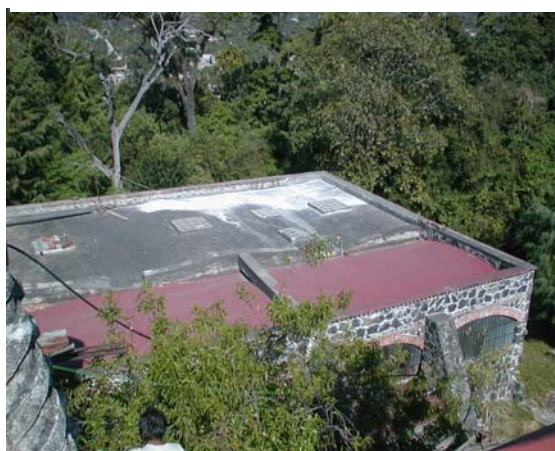
Techo de la casa habitación del monasterio que capta el agua de lluvia.
