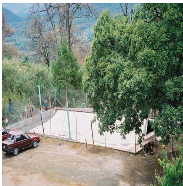
Olla de almacenamiento de 228 m 3 , en donde se deposita el agua antes del bombearse al hidrante.
