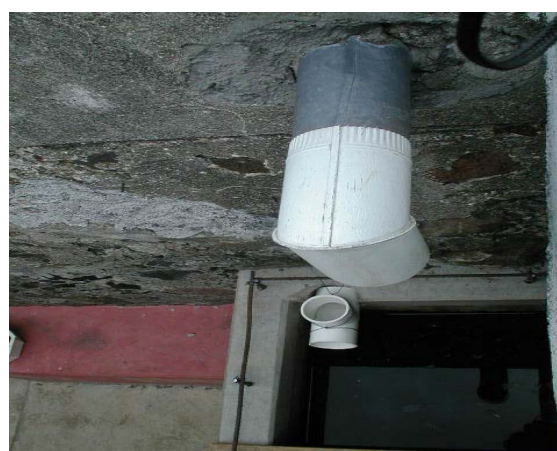
El agua captada por el techo cae en este pequeño depósito donde es dosificado con las pastillas de cloro.
