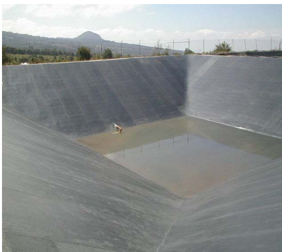
Actualmente una olla ha sido rehabilitada con geomembrana sintética, por el ayuntamiento de Totolapan.
