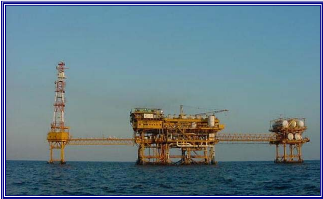
FOTO 16. PLATAFORMAS DE REBOMBEO.
