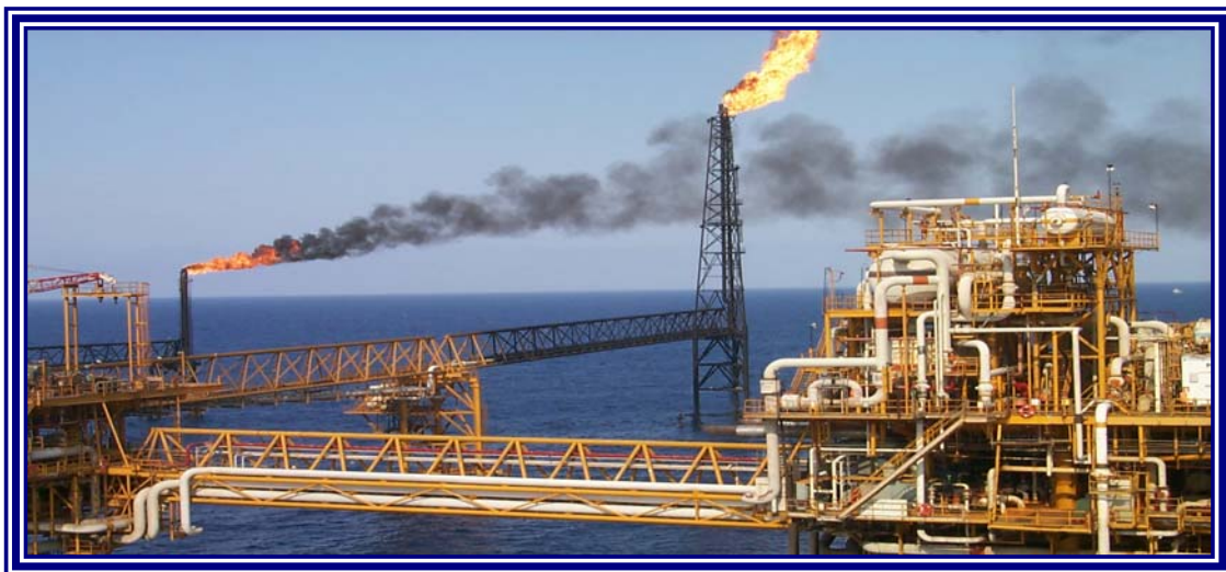
FOTO 20. PUENTE DE INTERCOMUNICACIÓN
