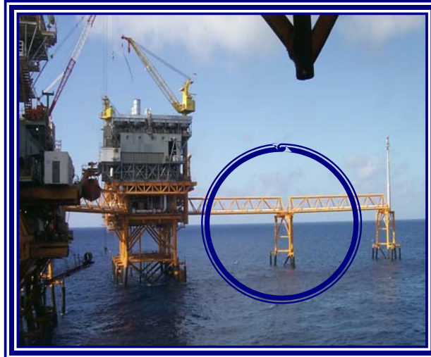
FOTO 18 PLATAFORMA DE APOYO INTERMEDIO (TRÍPODE)
