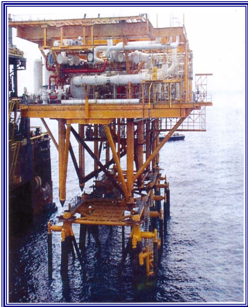
FOTO 3. SUPERESTRUCTURA EN INSTALACIÓN
