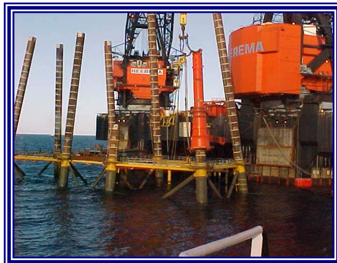
FOTO 5. INSTALACIÓN DE PILOTES
