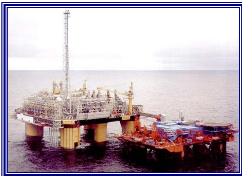
FOTO 8 PLATAFORMA TLP EN OPERACIÓN
