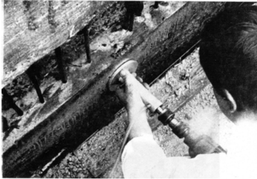
a) Barrenación del concreto
