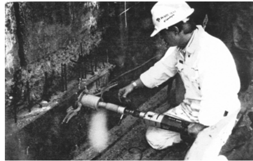
d) Barrenación del concreto para formar "corazón" a extraer.
