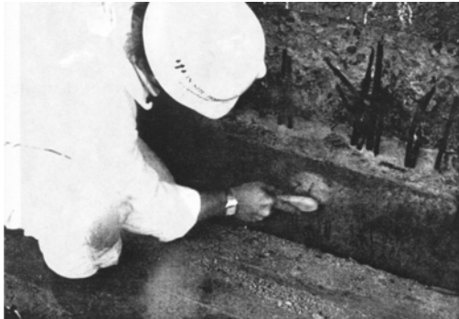
a) Limpieza de la superficie de prueba.
