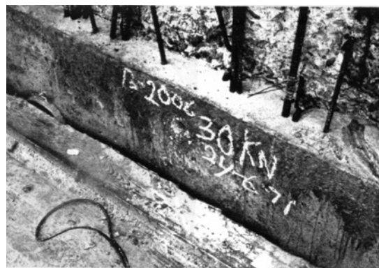
f) Aspecto final del concreto
