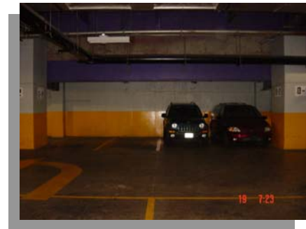
Entrepiso en estacionamiento
