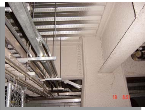
Detalle de losa acero y estructura de acero en nivel 17
