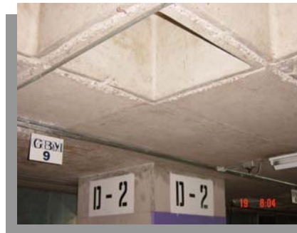
Losa de sótano
