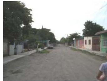
Avenidas de terracería
