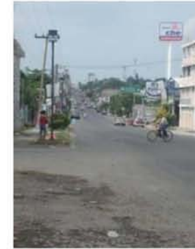
Calles en mal estado Facilidad de inundación
