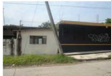
Graffiti y casas en mal estado
