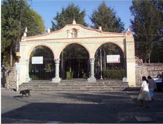
21. Fachada de la arcada real del atrio
