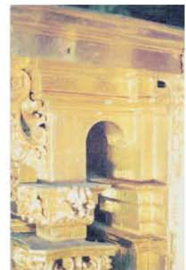
68. Trabe y friso funcionan como arco botarel
