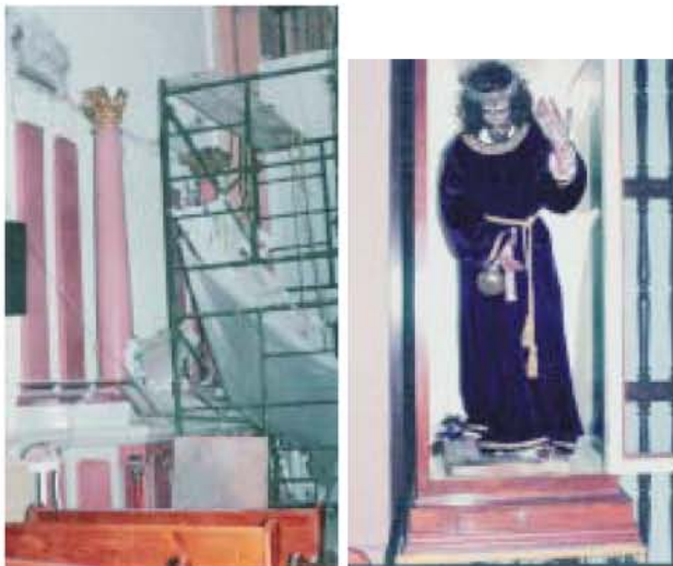
94. Demolición altar de cemento; 95 Nazareno en una vitrina
