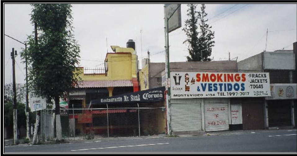
Fig. 41 Restaurante y casa habitación con local comercial.
