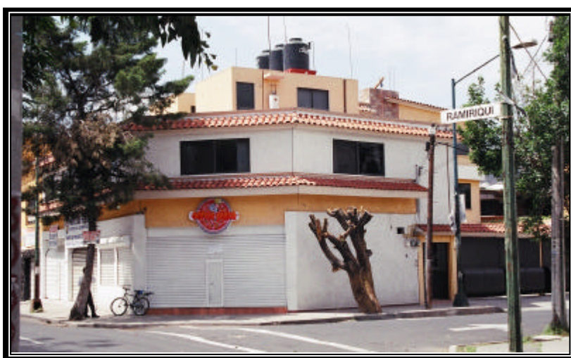
Fig.60 Esquina de Sierravista y Ramiriqui. En este lote se abrieron tres locales comerciales. La pizzería exactamente en la esquina y otros dos sobre la Av. Sierravista Se puede observar a la derecha de la fotografía y en segundo plano la construcción original, remetida del paramento de la calle y pintada de color anaranjado. En lo que era el jardín se hizo la nueva construcción que está pintada
