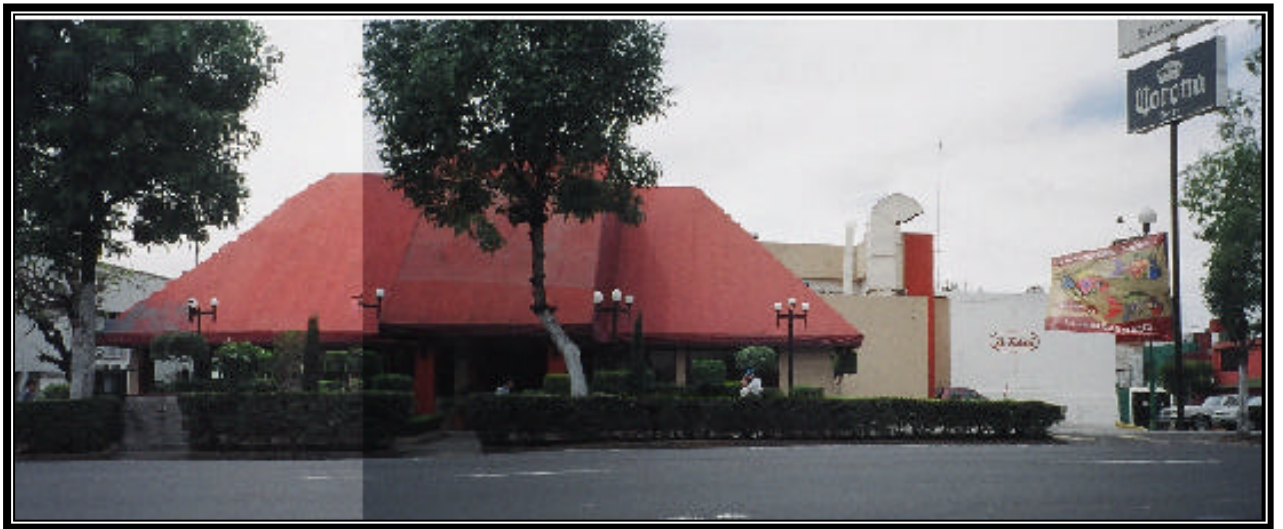
Fig. 42 Restaurante La Tablita sobre el Eje Cinco Norte Montevideo
