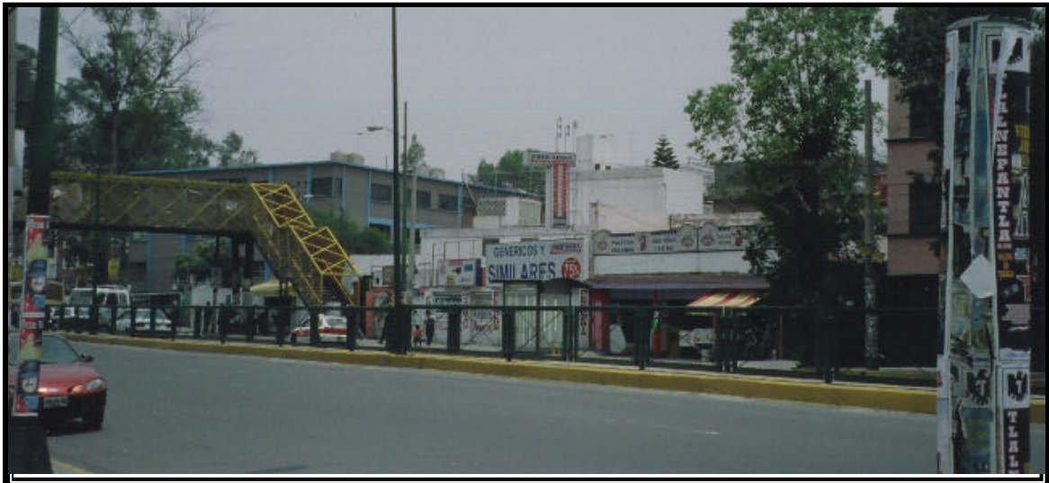
Fig. 37, bis En la Av. Ticomán frente a la estación Indios Verdes del metro. Prácticamente todas las construcciones unifamiliares han abierto locales comerciales, hacia la avenida sin disponer de estacionamiento
