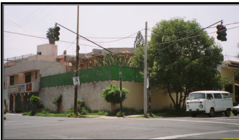
Fig. 11 Mutación en cerca Av. Riobamba esq. Sierravista
