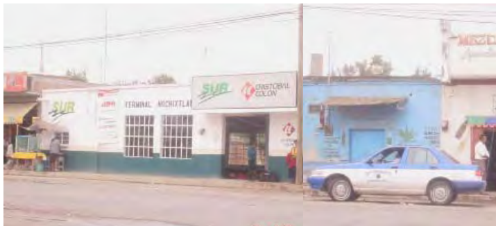
Estado actual de la terminal de autobuses de la línea Cristóbal Colón.
