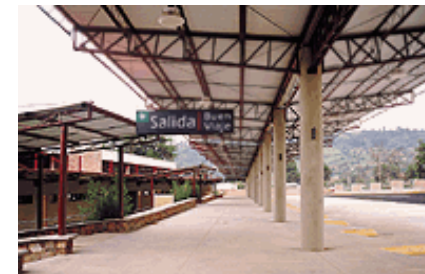
La terminal de Zitácuaro está definida como un organismo polifuncional. Fotografía que muestra el área de andenes.
