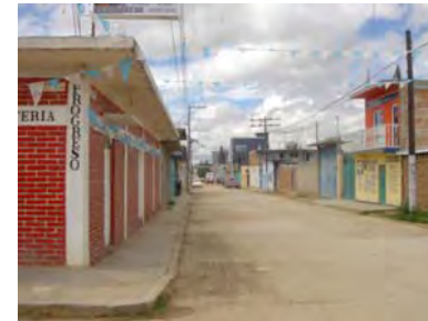
Como podemos observar el Municipio cuenta con drenaje, calles pavimentadas, luz, agua y guarniciones.
