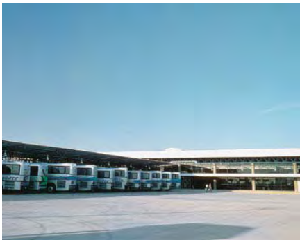
Patio De Maniobras.
