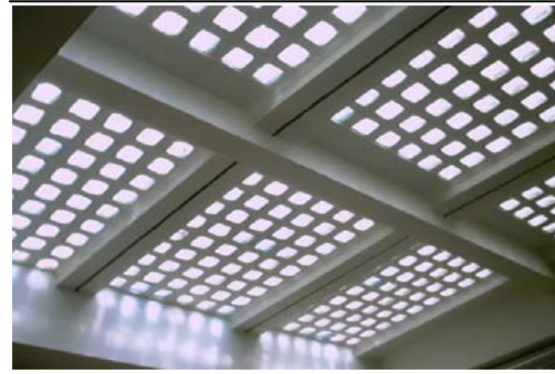
142.- Tragaluces. Acceso Hospital.
