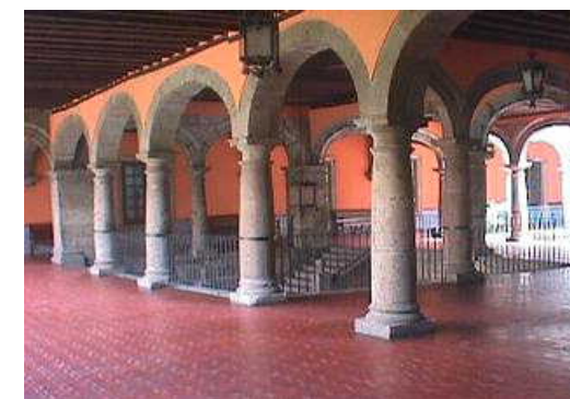
143.-Vista interior. Arcos de medio punto.
