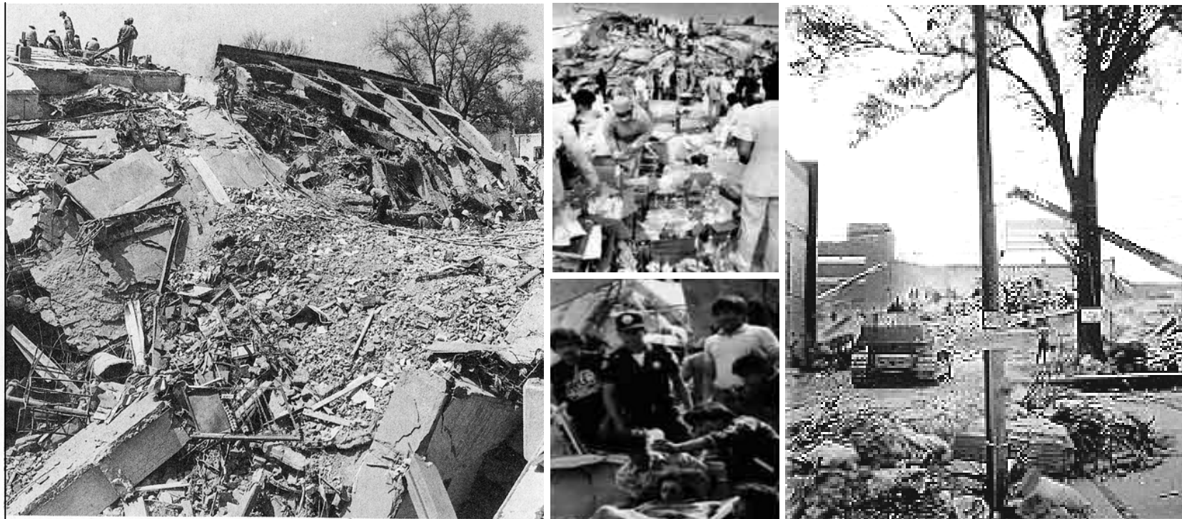
42.- Trabajos de rescate en la colapsada torre de hospitalización, septiembre de 1985.
