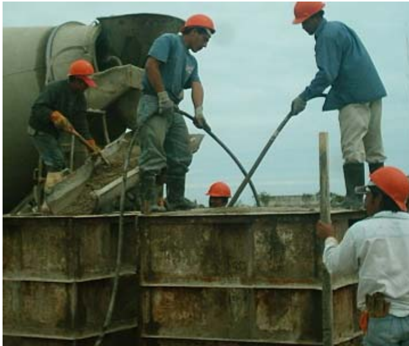
Figura V. 6 Vaciado y vibrado del concreto en moldes.
