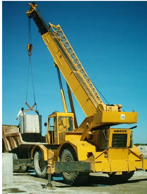
Figura V.12 Colocación de cubos en los camiones para su traslado a la escollera.
