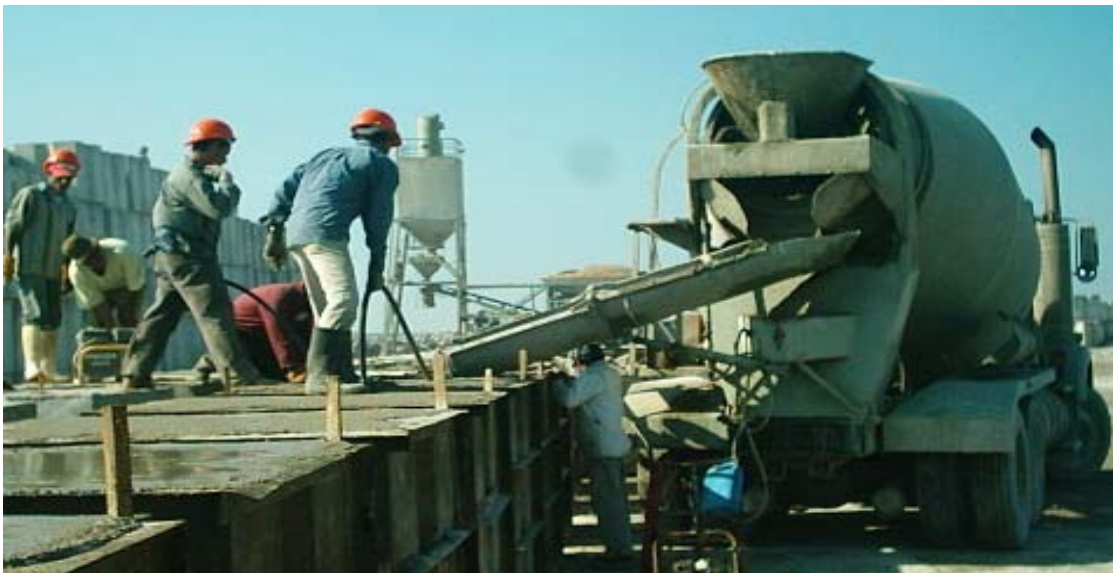
Figura 1.18 Vaciado de concreto en las cimbras metálicas.
