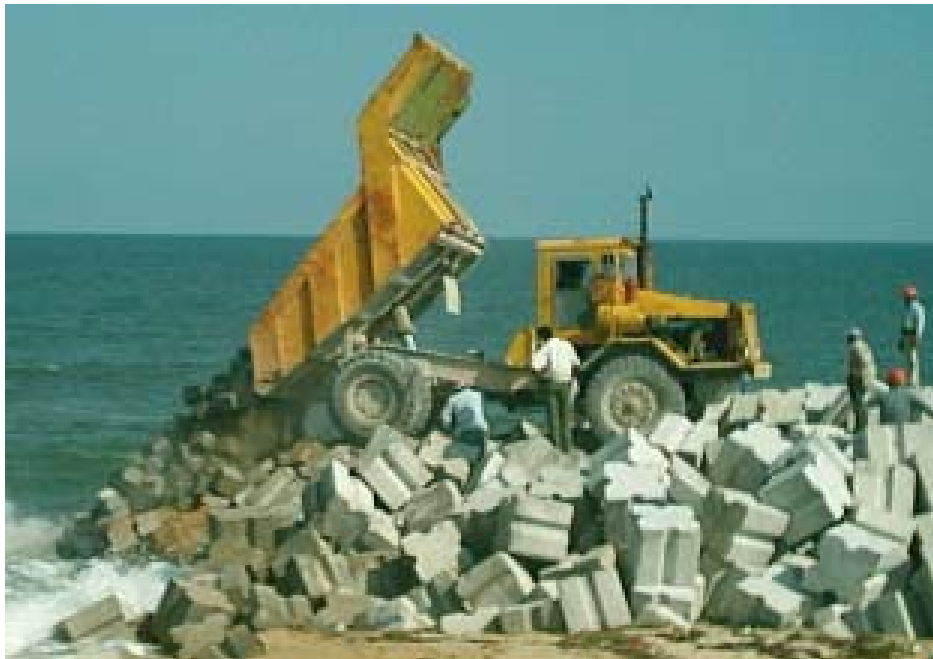
Figura V.9 Colocación del núcleo.
