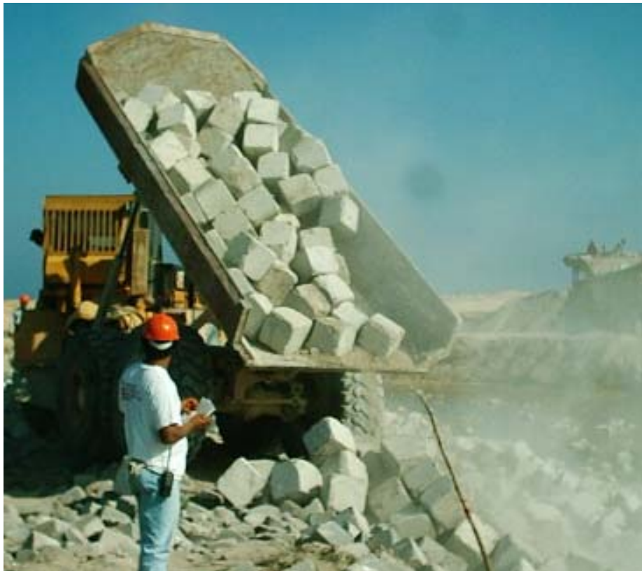
Figura V.11 Colocación de la capa secundaria a ‘tiro directo’.
