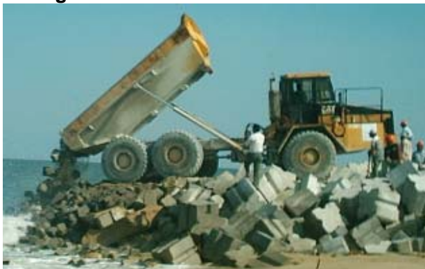
Figura 1.9 Camión colocando núcleo.
