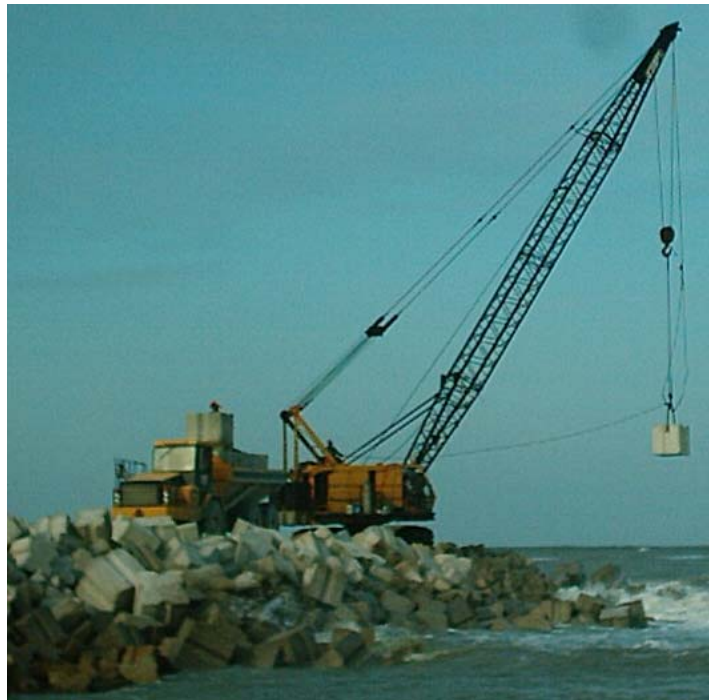
Figura V.13 Colocación de cubos para coraza en la escollera.
