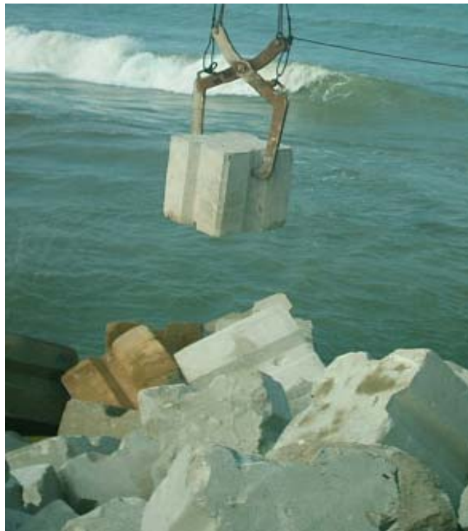
Figura V.14 Colocación de cubos “uno a uno”.
