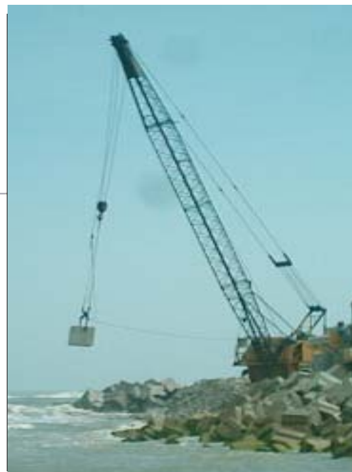
Figura 1.4 Grúa mecánica colocando un cubo.
