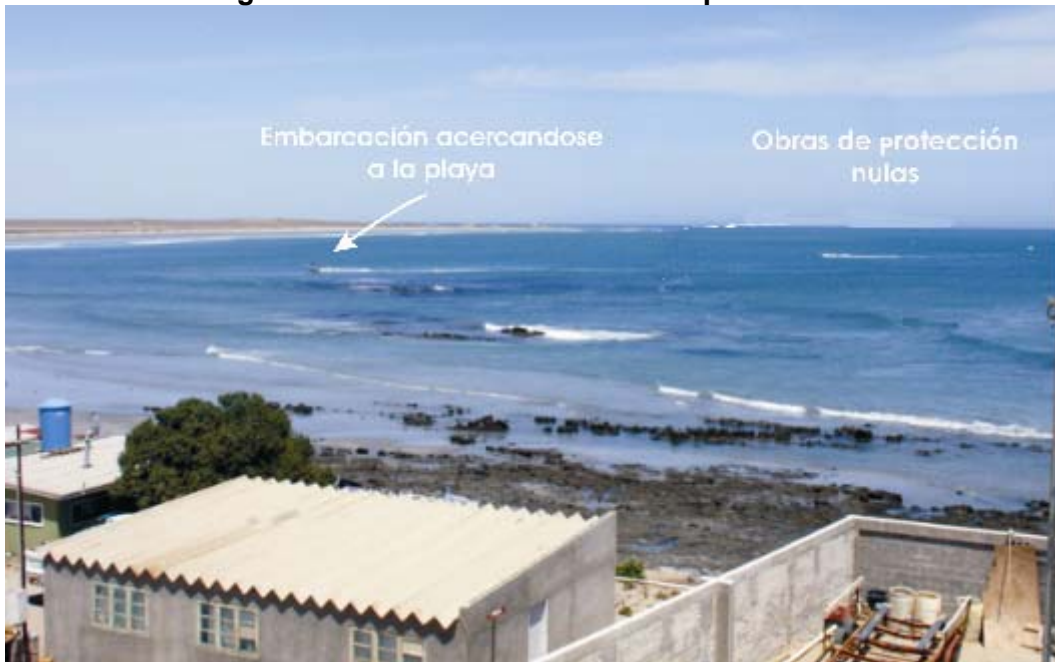
Figura III.23 Carencias de obras de protección.
