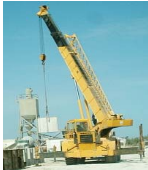
Figura 1.2 Grúa hidráulica moviendo un cubo del patio de colado.
