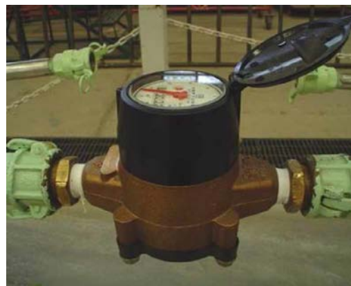
Ilustración 6.2 Medidor tipo velocidad.
