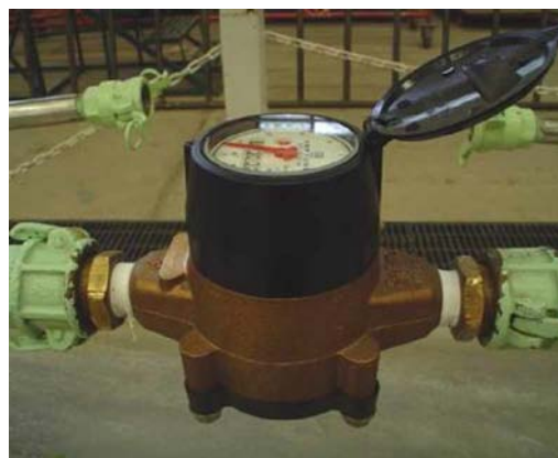
Ilustración 3.2 Medidor tipo velocidad.
