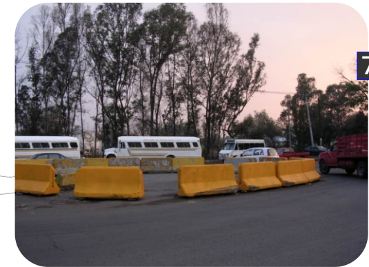
Foto 2. Retorno en la parte oriente del puente
