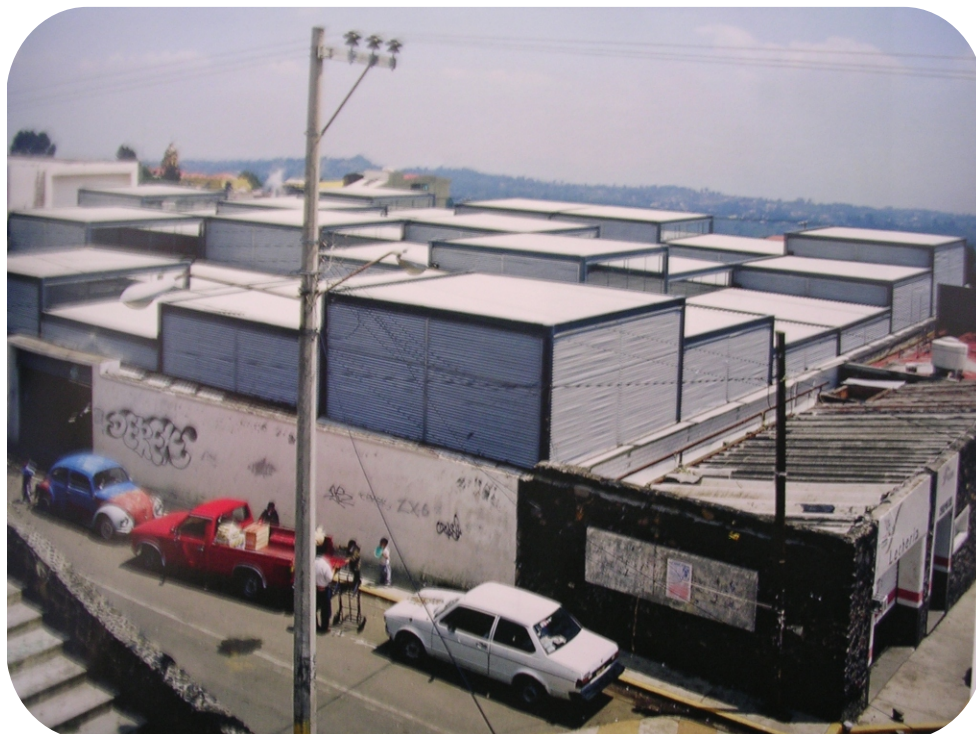
Vista de los módulos de 6 X 6 y de las distintas alturas de las cubiertas, además de la ventilación e iluminación la estructuración de la cubierta y su integración con el entorno.
