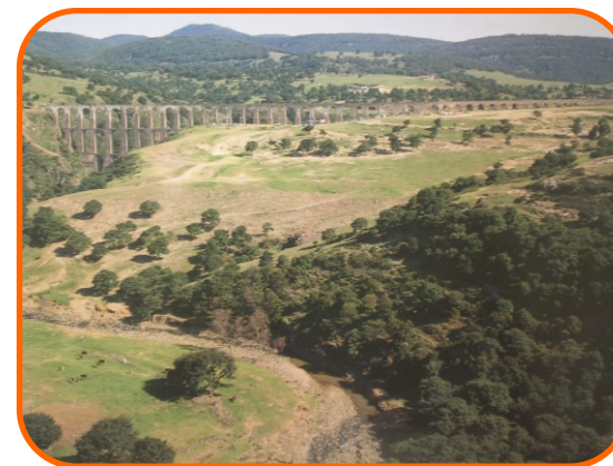
ACUEDUCTO ARCOS DEL SITIO
