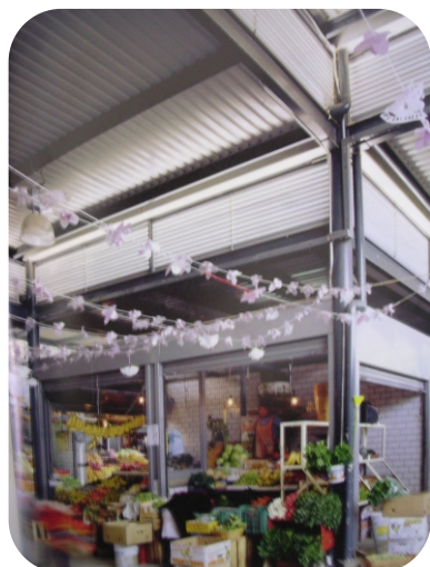
Vista de los módulos de los puestos y la estructuración de la cubierta
