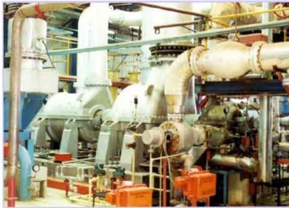
Figura III.11 Sistema de extracción de gases a base de turbina y compresor.
