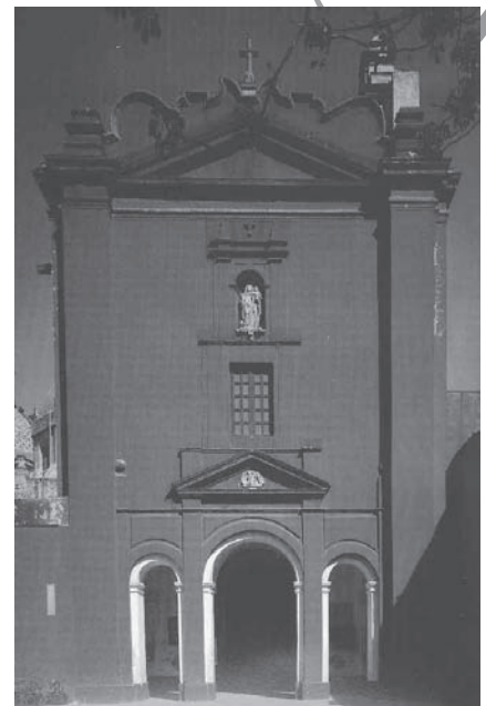
Fachada principal de la iglesia de El Carmen de San Ángel.
