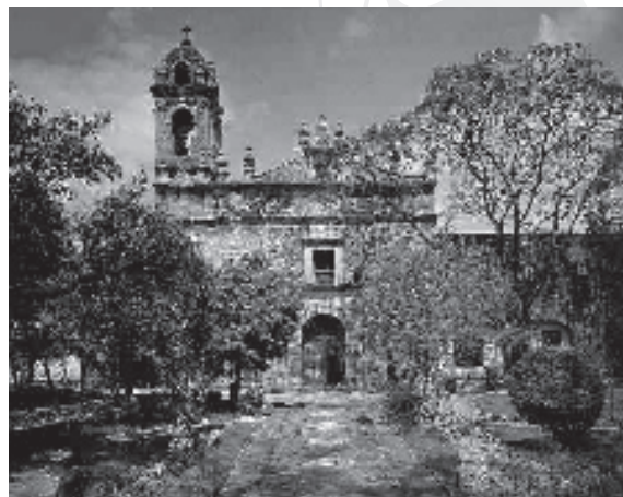
El atrio de San Jacinto en San Ángel, en vista frontal a su fachada principal.
