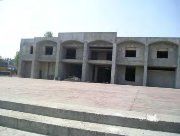
76. Obra para la Delegación demolida a fines de 2003-2004.
