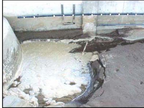
Cono de socavación, 60 min. en modelo.
