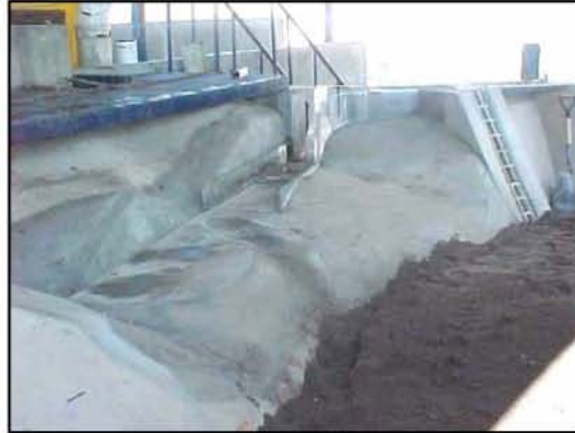
Canal sedimentador-desarenador y obra de toma
