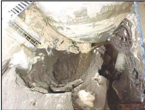
Cono de socavación, 90 min. en modelo.
