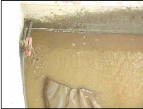
Desagüe de fondo obstruido, 75 min. en modelo.
