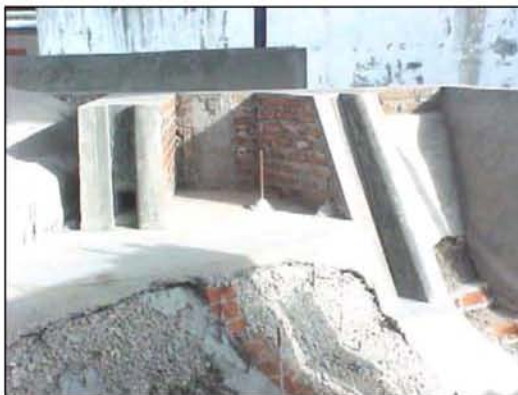
Obra de toma nueva y desarenador.
