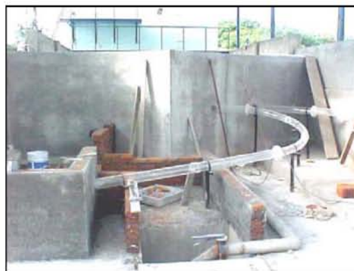
Túnel de descarga del desarenador
