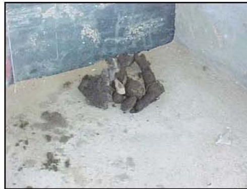
Las piedras arrastradas por el flujo obstruyeron la estructura de rejillas
