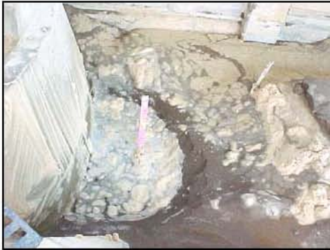
Cono de socavación, 110 min. en modelo
