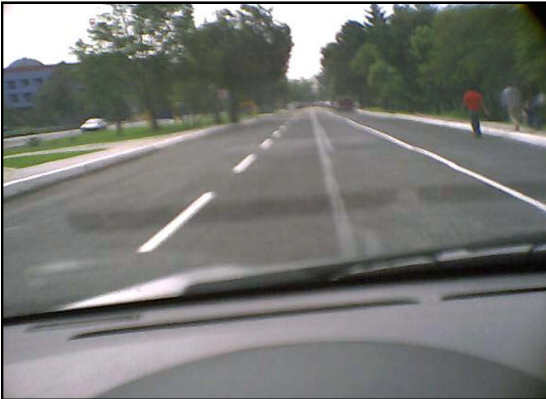
Figura 1.7. "Ampliación de los carriles sobre el Circuito Cultural de Ciudad Universitaria". Elaboración Propia. 2005.
