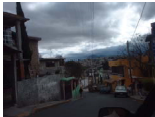
Viviendas en mal estado en el contexto inmediato
