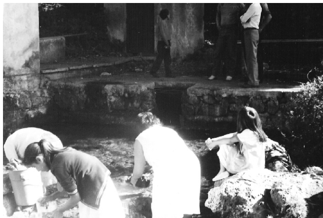
3 Noviembre de 1990: La gente aún lavaba su ropa en la presa
