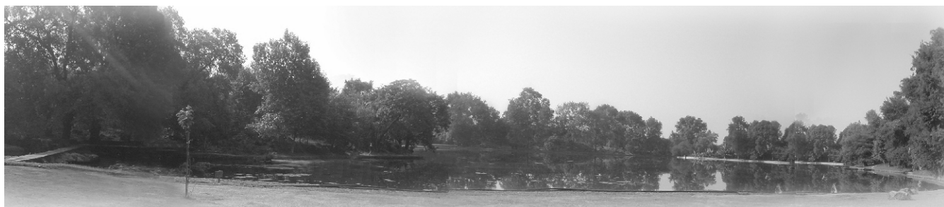
Imagen actual de la presa Santa Catarina
