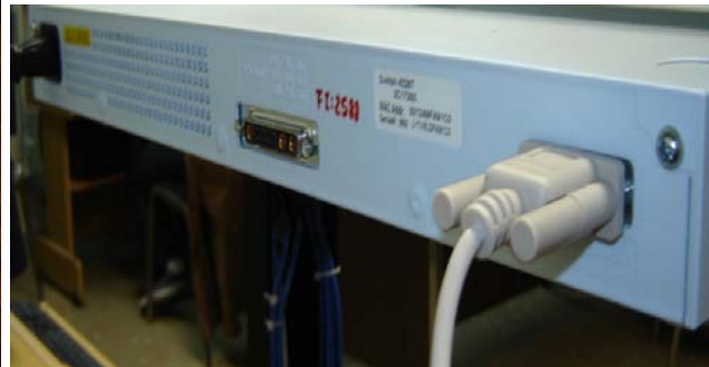
Figura 2.40 Conexión de los cables
