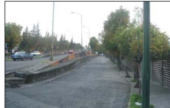
Fotografía 7 Vista al viaducto Río Becerra y a su lateral
