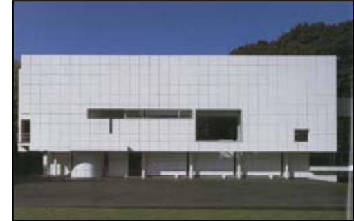
Fachada de prefabricado
