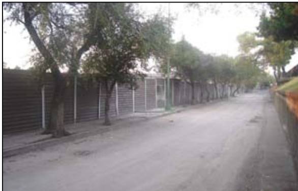
Fotografía 6 Lateral Viaducto Río Becerra
