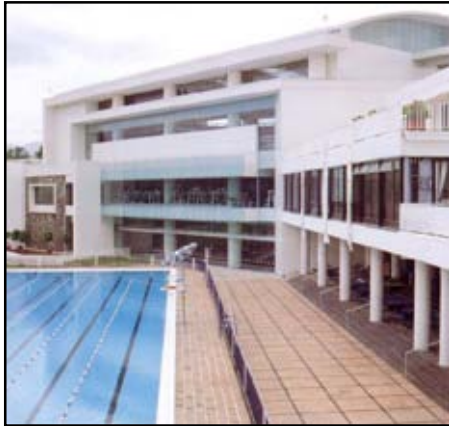
Fachada y exterior del club
