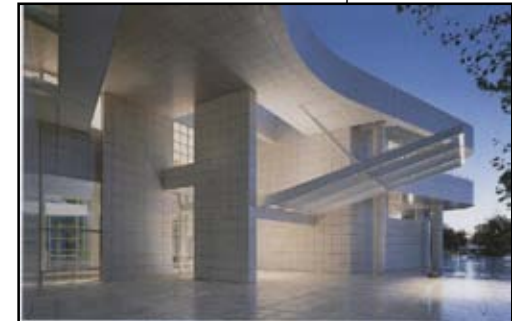
Volumetría de fachada de acceso
