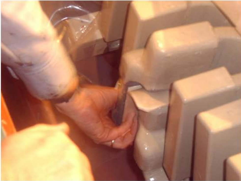
Figura 4.6 Revisión y limpieza del estator
