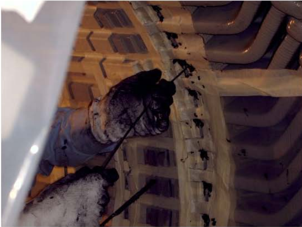
Figura 4.7 Maniobra de la inyección de resina
