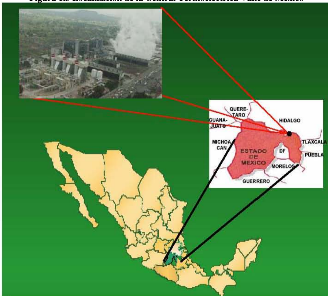
Figura 1.3 Localización de la Central Termoeléctrica Valle de México
