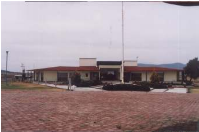
EDIFICIO DE GOBIERNO (VILLAS OCARANZA) ESTADO DE HIDALGO
