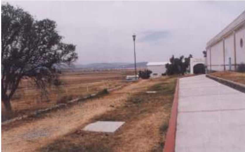
ENTRADA A VILLAS OCARANZA ESTADO DE HIDALGO TEMPORAL
