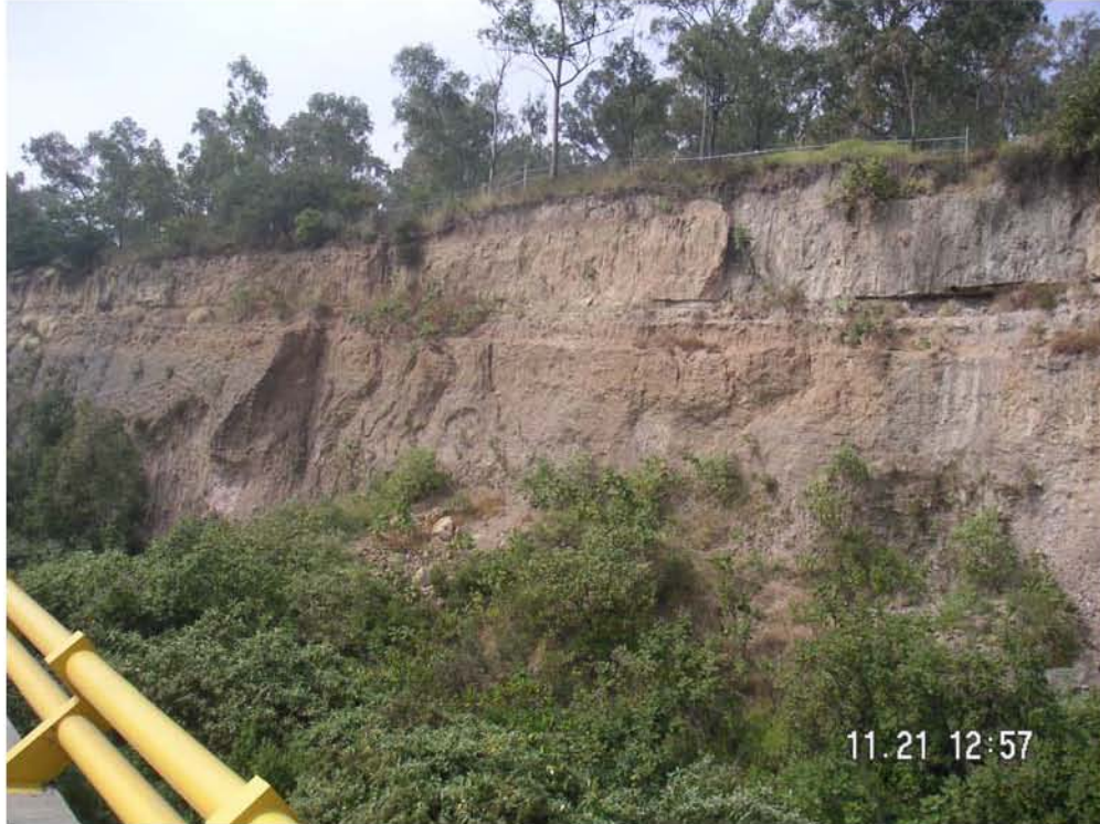
Foto 2. Panorámica de un corte sobre la autopista México-Toluca, sitio Puente; se observa en la porción superior la Capa Dura de color grisáceo descansando sobre una toba de color gris que se erosiona con facilidad formando cavidades.
