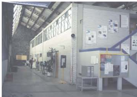
Toma de frente al Edificio del Centro de Diseño y Manufactura
