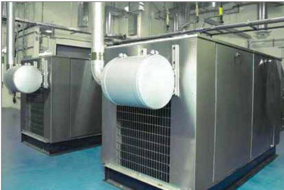
Figura 4.10 Modulo de energía de 125 kW de Stuart Energy.
