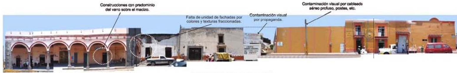
FACHADA PONIENTE DE LA PLAZA
