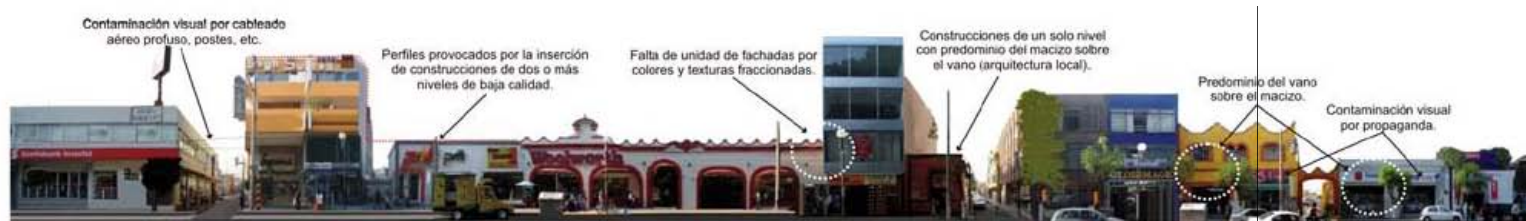
FACHADA NORTE DE LA PLAZA
