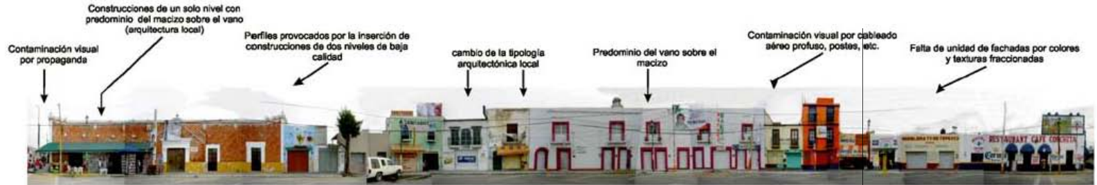
FACHADA NORTE DE LA PLAZA
