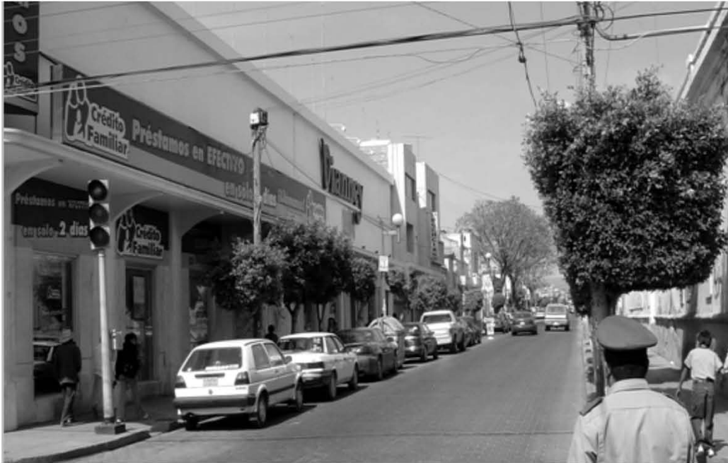
Ilustración 34. Fotografía actual tomada por: Francisco Sotomayor. (Marzo 2005). Apreciamos cambio de pavimentos, sustitución de arquitectura histórica por construcción del siglo XX, contaminación visual, cables y letreros.
