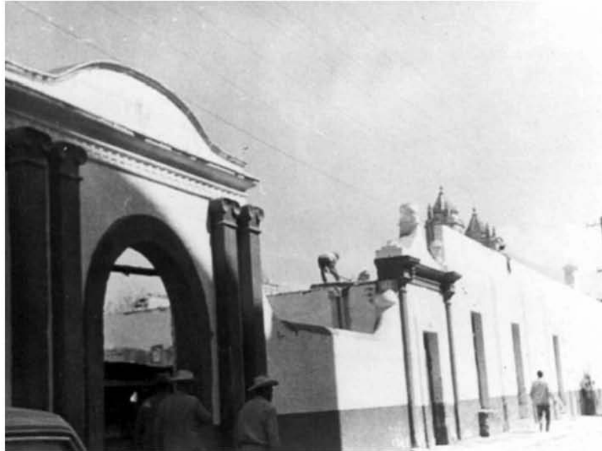
Ilustración 75. Chalchicomula. Callejón de la 16 de Septiembre (Antiguo Mercado) . En el análisis secuencial observamos diferencia, perfiles y podemos apreciar el inicio del proceso de demolición del mercado. (Archivo del autor).
