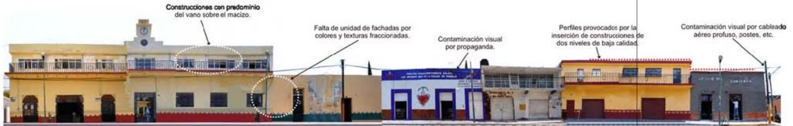
FACHADA NORTE DE LA PLAZA
