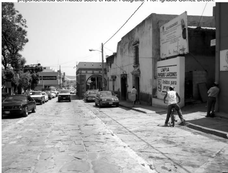
Ilustración 10. Aspecto del portal Juárez y la calle del mismo nombre, 2005. A diferencia del resto de las poblaciones en esta calle de Tecamachalco, persiste el pavimento de piedra, aunque las construcciones históricas en gran parte han sido destruidas. Nuevamente el automóvil tiene una presencia significativa y la contaminación visual como en el resto de la población es evidente. Fotografía, archivo del autor.
