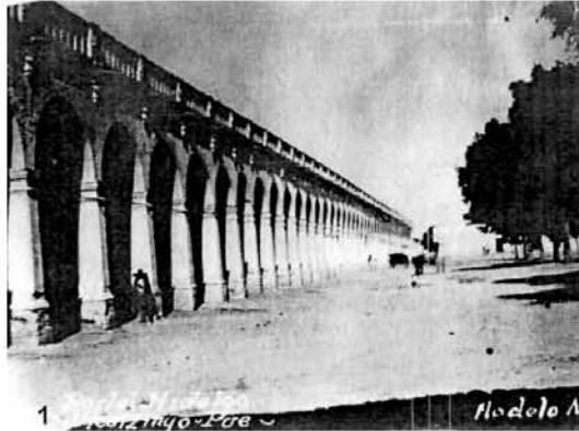
Ilustración 15. Acatzingo. Portal Hidalgo. Av. Rodolfo Sánchez Taboada. Correspondiente a principios del siglo XX, se aprecia la sección de la calle sin algún tipo de pavimento y definición lateral con la presencia de vegetación y estrechamiento. El material manejado en la arcada es el aplanado y resalta la pérdida de material en las basas de las columnas. Fotografía, Prof. Pablo Valencia.
