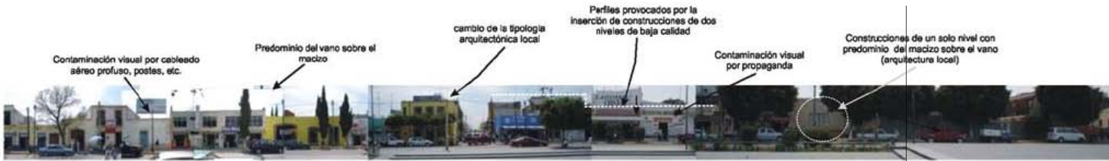
FACHADA PONIENTE DE LA PLAZA
