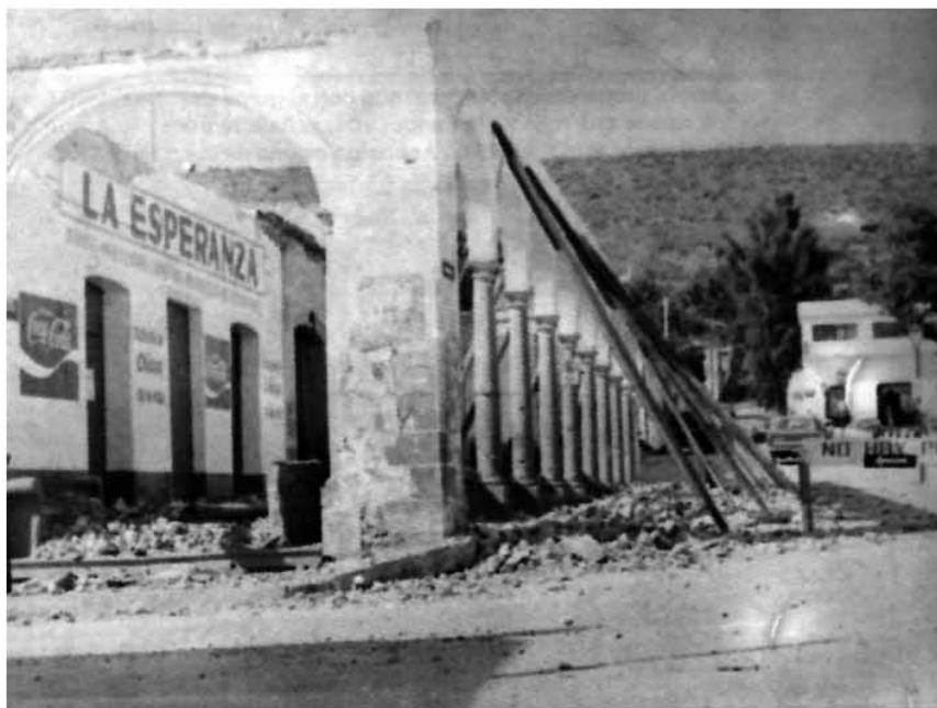
Ilustración 3. Tecamachalco. Aspecto del único portal, construido el 5 de Mayo de 1869, en días posteriores al sismo de 1973. Como es fácil apreciar el sismo hizo caer la cubierta de terrado y vigería, se observan las medidas preventivas de apuntalamiento que se tomaron para mantener en pie la arcada. Fotografía: Prof. Ignacio Gómez Bretón.
