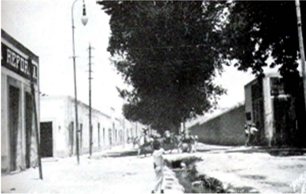
Ilustración 33. Tehuacan. Calle 6° de Juárez esquina con 5 sur entonces 4° de la 5 de Mayo, hoy, Calle 3 Oriente. Observamos perfiles, diferencia de niveles y es de destacarse la presencia de un drenaje a cielo abierto, además de los típicos árboles a mitad de la avenida
