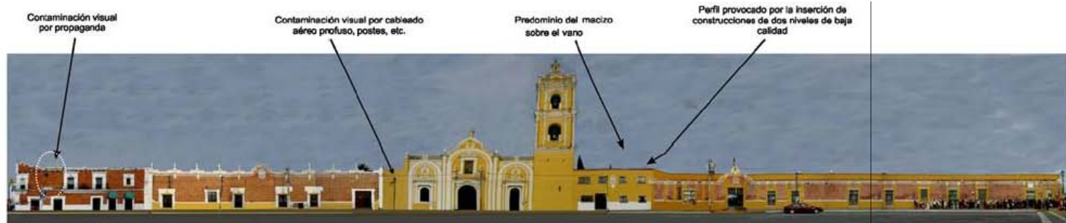
FACHADA PONIENTE DE LA PLAZA
