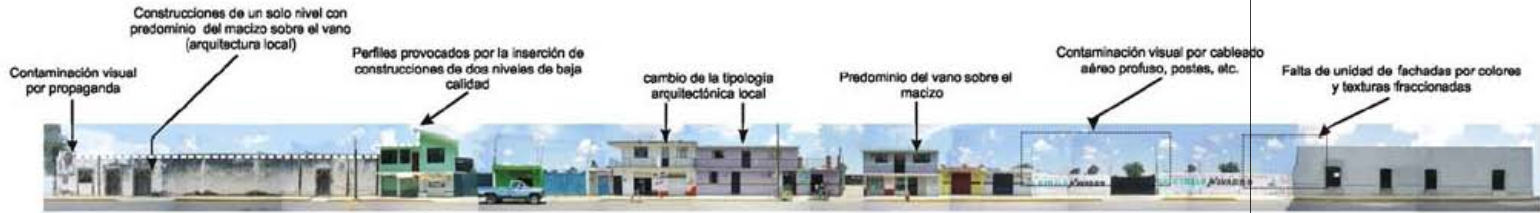
FACHADA PONIENTE DE LA PLAZA
