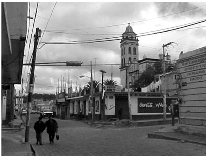
Ilustración 72 Fotografía actual. Se aprecia degradación de la imagen por la sustitución de las edificaciones históricas por construcciones de ínfima calidad. Colocación de vegetación y contaminación visual por postes, cables, columnas sin terminar y anuncios. Cambio de la pintura de la parroquia, con colores totalmente ajenos a la historia del edificio. (Fotografía del autor, octubre 2001).
