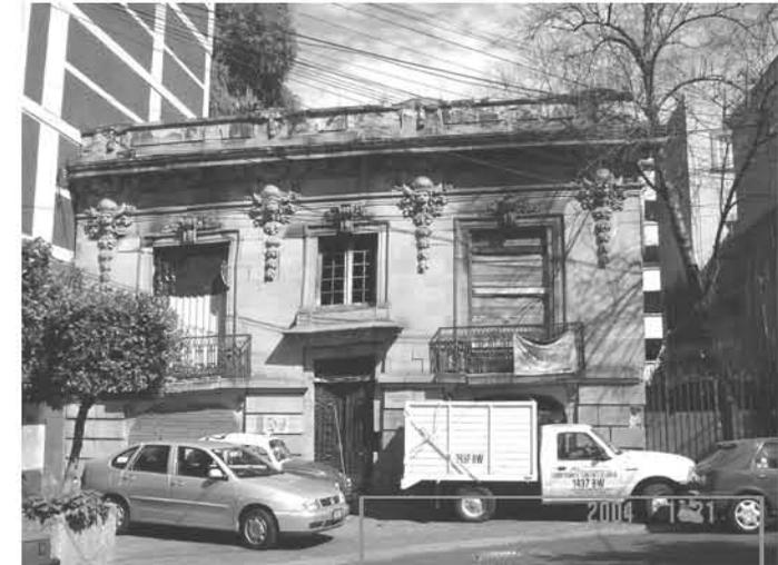
Imagen que muestra el deterioro de un edificio porfiriano a causa de los esfuerzos provocados por su colindante.
