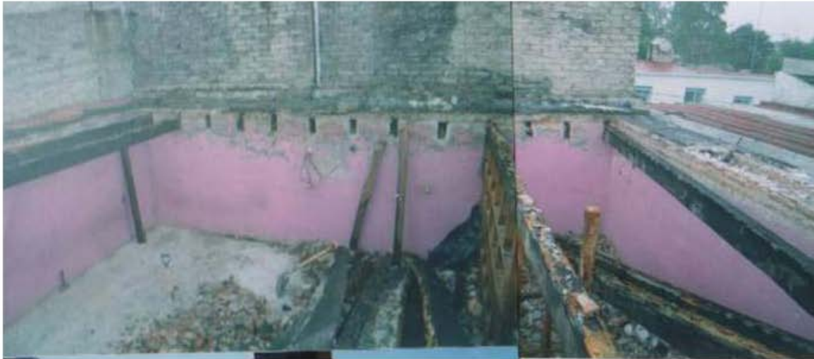
Demolición de la cubierta dañada
