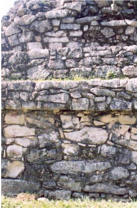
Figura 24. Película negra rugosa en el basamento.
