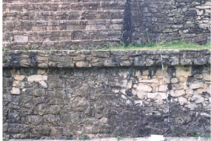
Figura 25. Vista de la película negra en el basamento.
