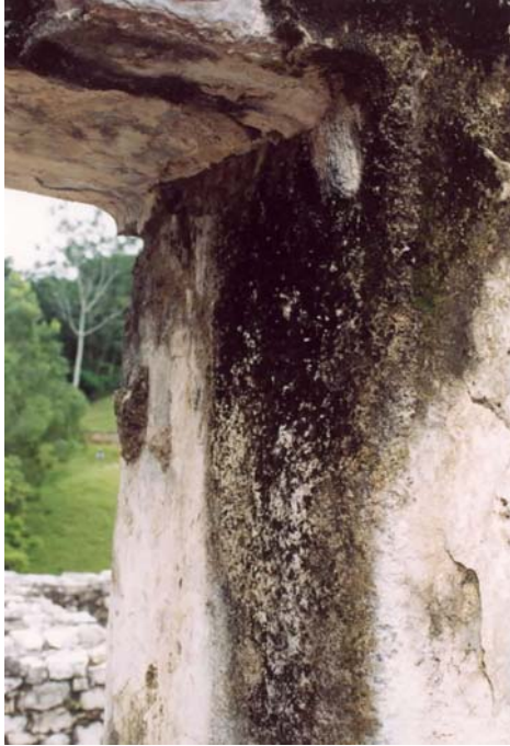
Figura 22. Crecimiento a manera de escurrimiento (mucilaginoso).
