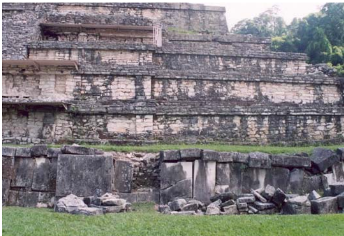
Figura 45. Vista de las manchas negras sobre el basamento.
