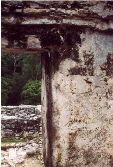
Figura 19. Película negra a manera de escurrimiento.
