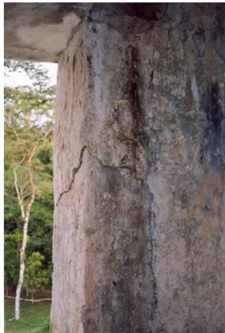
Figura 8. Detalle del escurrimiento en el pilar.
