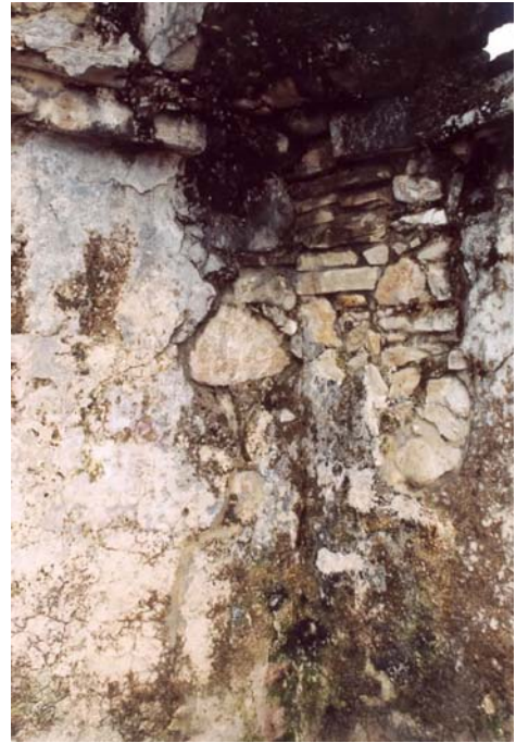
Figura 20. Películas negras sobre los muros de la crujía.
