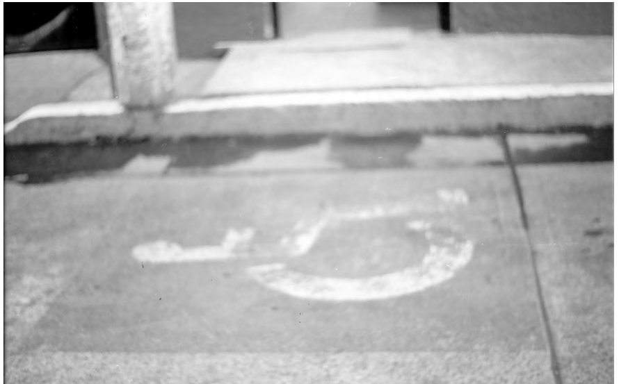
NO TODAS LAS RECOMENDACIONES PARA LA CONSTRUCCIÓN DE ESTACIONAMIENTOS SON ACATADAS . Fig.29
