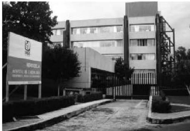
Fotografía 2.4. Hospital de Cardiología del Instituto Mexicano del Seguro Social que fue reforzado usando pórticos contrafuertes luego del sismo de México 1985 *
