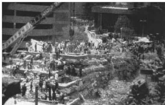
Fotografía 1.5. Colapso total del Hospital Benito Juárez, México, EQ 1985
