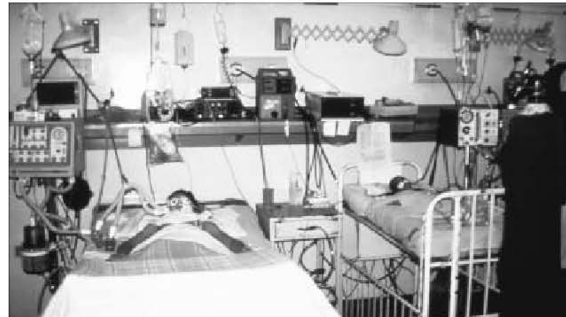
Fotografía 1.3 La vida de algunos ocupantes del hospital depende del correcto funcionamiento de equipos y la continuidad de suministros básicos como electricidad y gases
