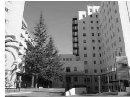
Fachada principal hospital general, vista lateral del edificio
