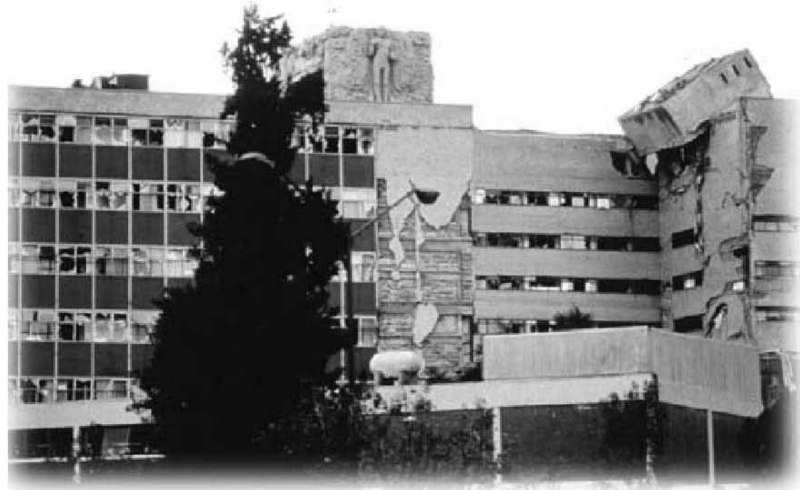
Fotografía 2.1 Concentraciones de masa, tales como estanques de agua en el techo de hospitales pueden producir daños que comprometan el funcionamiento del hospital. Tomada de la edición de la OPS y la OMS "Fundamentos para la Mitigación de Desastres en establecimientos de Salud" serie mitigación de desastres. Washington, D.C.; 2000
