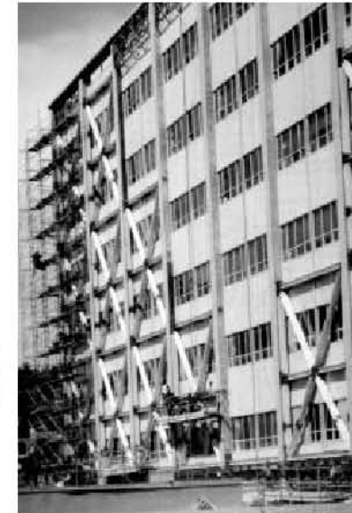
Fotografía 2.3 Refuerzos con diagonal
