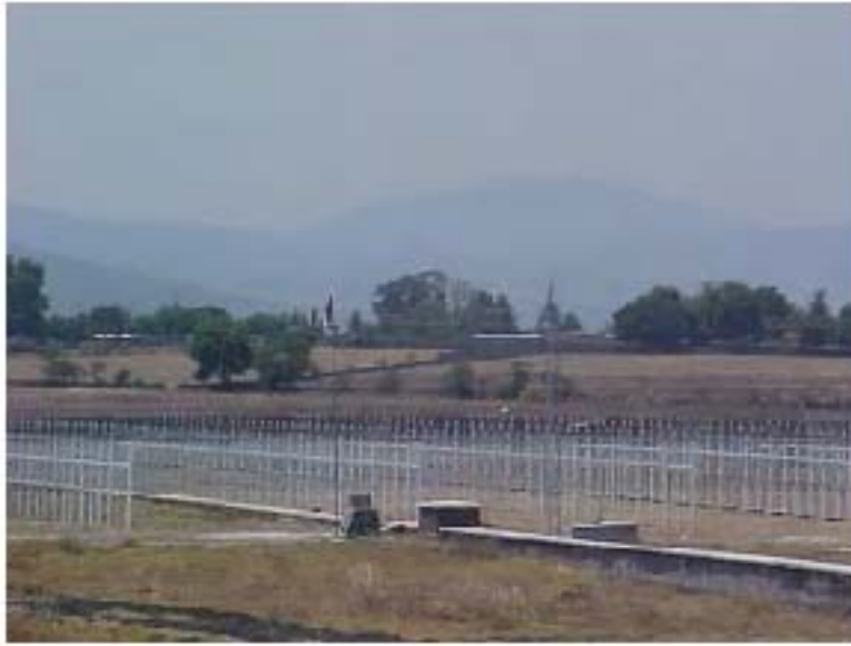
Figura 23: Plataforma del arreglo dipolar del radiotelescopio, cuya superficie es aproximadamente de 12\,000\text{ m}^2 .
