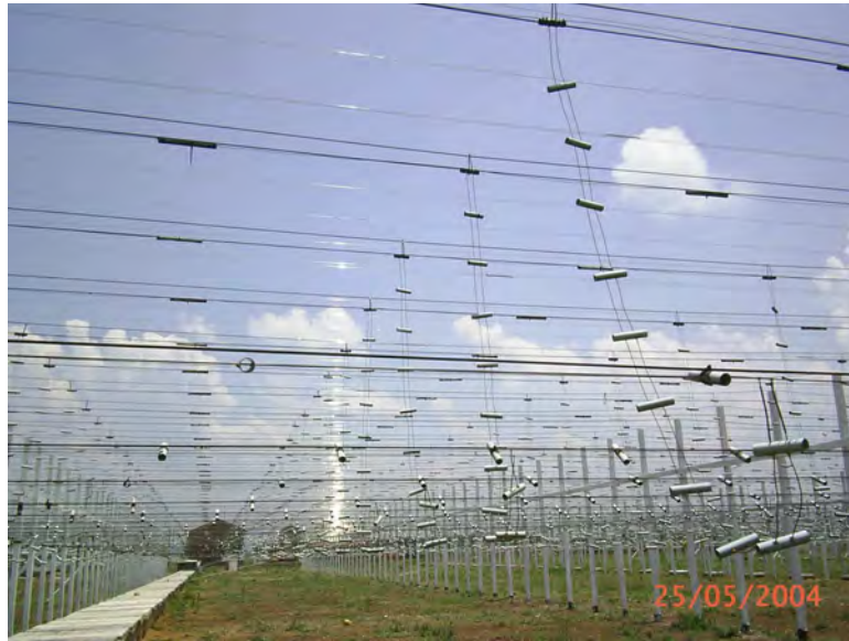
Figura 24: Tendido de dipolos de cada línea del arreglo dipolar.
