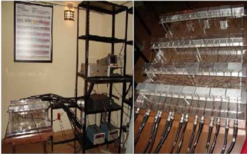
Figura 8: (a) Implementación de la Matriz de Butler de 16 puertos en el cuarto de control del MEXART. (b) Alimentación de la Matriz de Butler con las antenas del arreglo dipolar.
