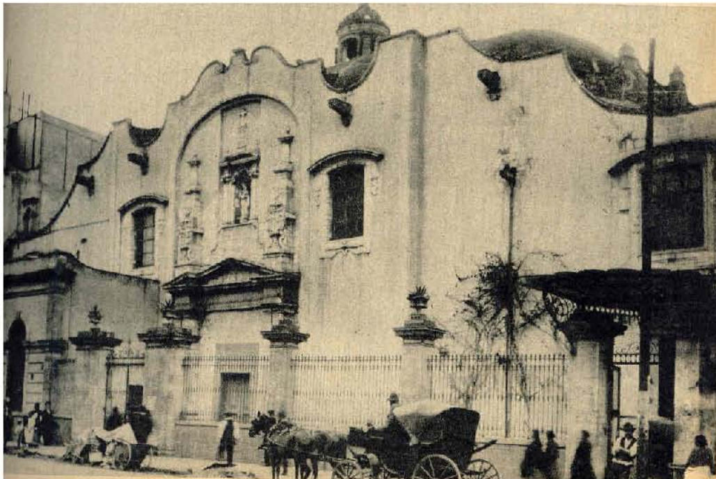
Iglesia de Santa Brígida - Aspecto de la fachada en las primeras décadas del siglo XIX (Imagen: de Crónica del Convento... , I.I.H.-U.N.A.M.)
