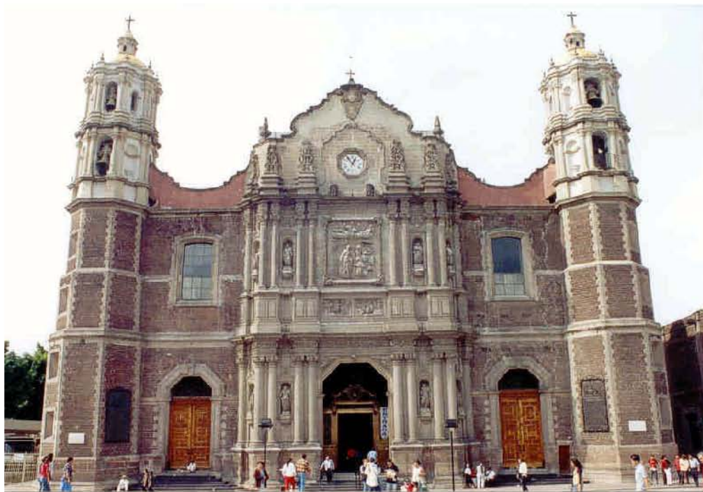
Basilica de Guadalupe - Fachada principal de la antigua basílica; sus columnas interiores tienen ahora un cinturón de concreto a lo largo de todo el fuste, debido a los severos problemas estructurales que presenta.
