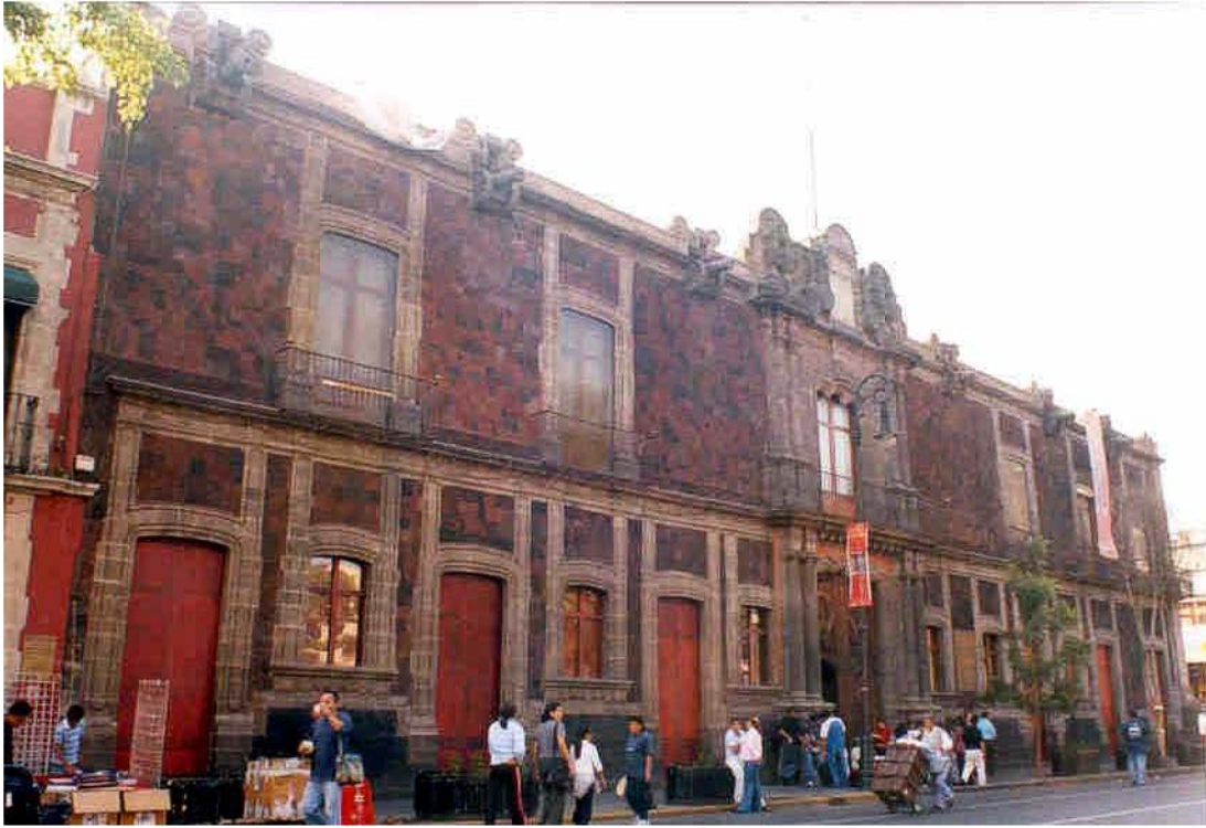
Palacio de los Condes de Santiago de Calimaya – Perspectiva de la fachada principal sobre la calle de Pino Suárez; es fácil apreciar el estilo que Guerrero y Torres imprimió a sus obras, conocido por algunos autores como estilo mexicano .
