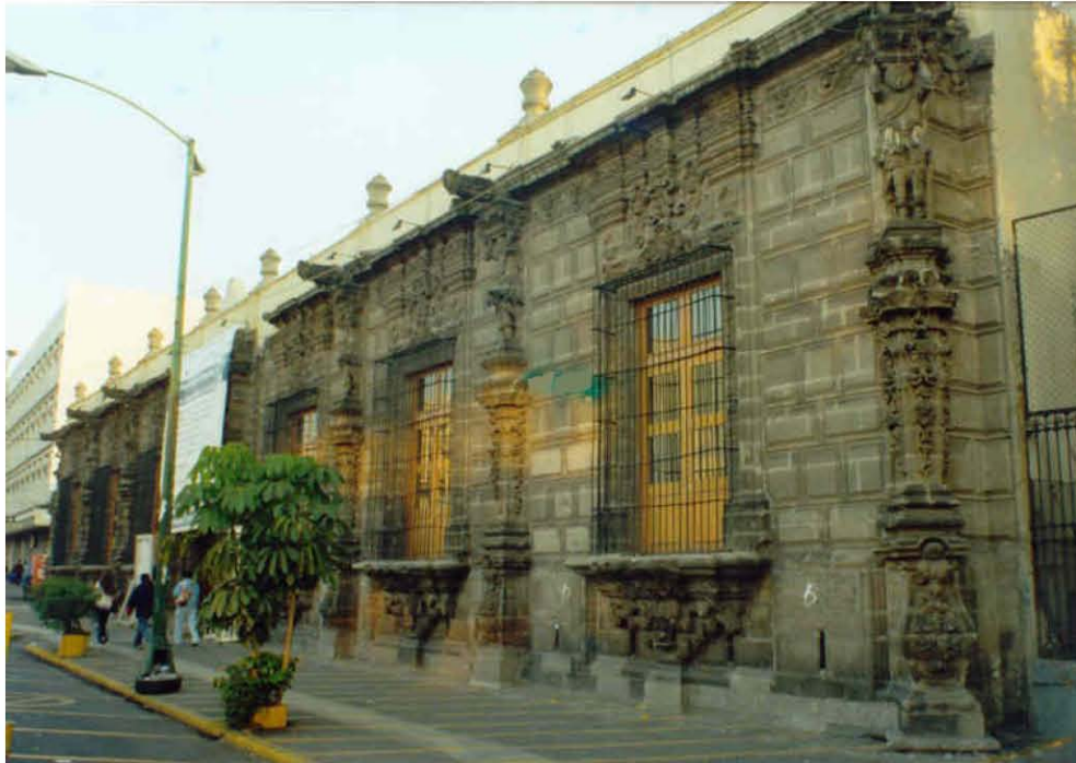
Casa de Campo de los Condes del Valle de Orizaba - Perspectiva de la conocida Casa de Los Mascarones (1766-1771), que en realidad son cariátides que rematan a las pilastras estípites; la construcción nunca se concluyó, no así la fachada que le ha dado identidad y renombre al edificio.
