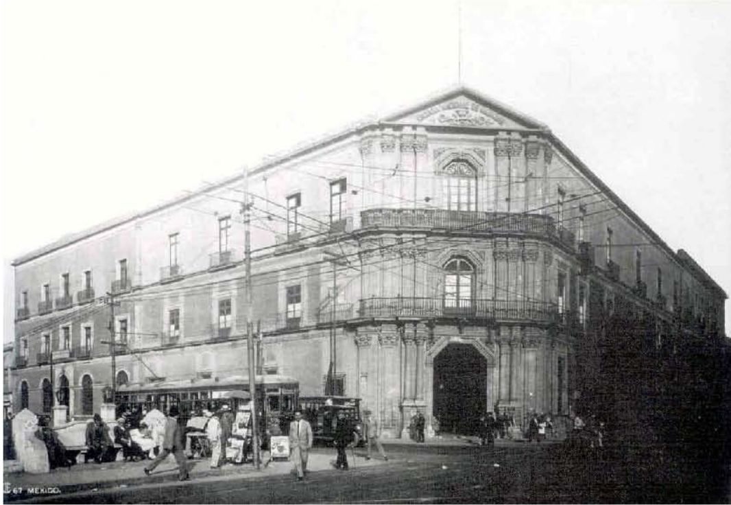
El Palacio de la Inquisición - Vista de la esquina ochavada que da hacia la plaza de Santo Domingo, cuando el edificio fue ampliado con un nivel extra, a mediados del siglo XIX. Afortunadamente, en una restauración posterior este piso fue liberado y el inmueble recobró sus proporciones originales, al igual que la plaza; incluso el inafrente que contenía el escudo de la Inquisición fue rehecho en base a fotografías e ilustraciones anteriores a la demolición.
