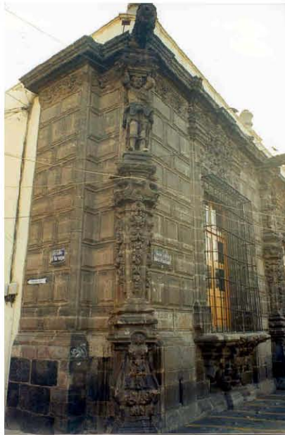
Casa de Campo de los Condes del Valle de Orizaba - Detalles de pilastras estípites de esquina e intermedia; en cada caso se remata con una gárgola cilíndrica también labrada inserta en la cornisa superior.
