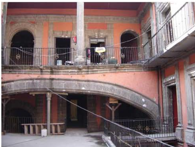
La casa del Conde de San Bartolomé de Xala - Luego del desalojo de los últimos inquilinos, en los primeros meses de 2005, tal era el estado del patio y sus anexos. La superficie que se aprecia en la parte inferior es el lecho alto de la losa de concreto que invade casi todo el patio. En el arco, se lee: Se acabó el 31 de Julio de 1764 años; la hizo D. Antonio Rodríguez de Soria y el Maestro D. Lorenzo Rodríguez.
