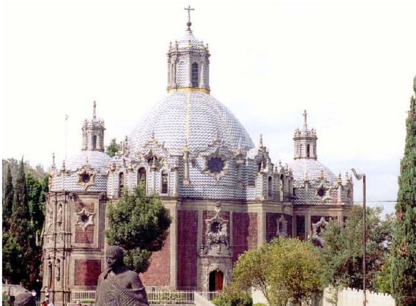
Capilla del Pocito - Entorno actual; los espacios adosados que por mucho tiempo estuvieron conviviendo con el edificio ya no existen, y es posible circundarlo a pie sin problema.
