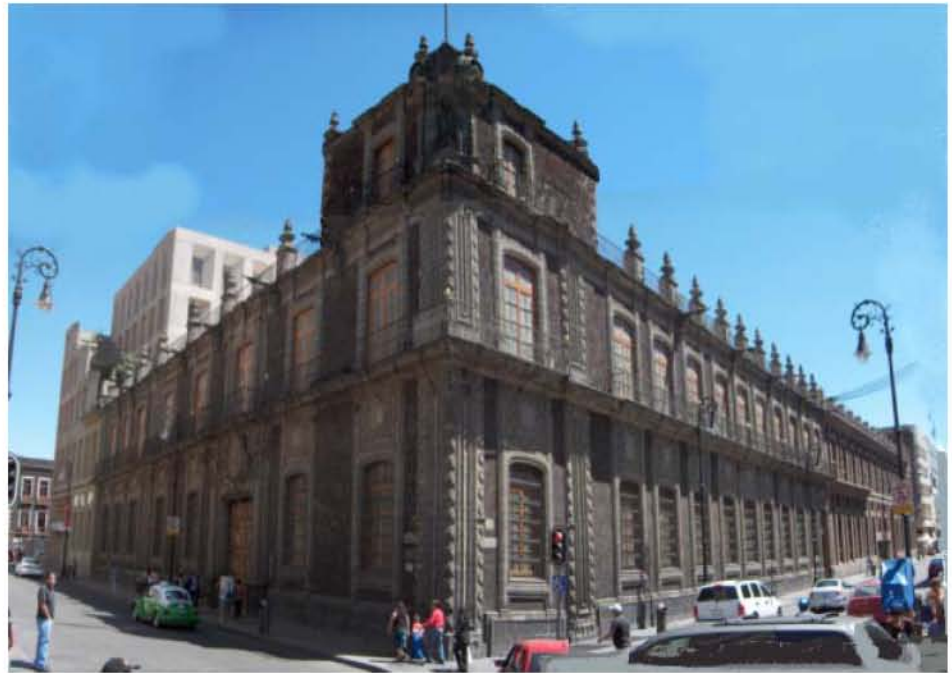
Palacio de los Condes de San Mateo de Valparaíso - El edificio es uno de los mejor conservados hoy en día gracias a que pertenece a una institución bancaria, que le presta atención constante.
