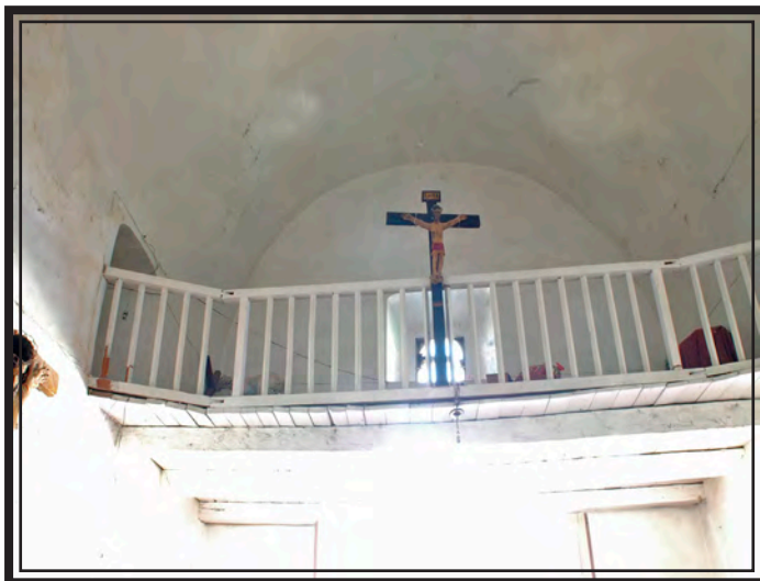
Fig. 11 Coro y sotocoro hecho de viguería de la visita de Amajatlán (foto: Eumelia Hernández)
