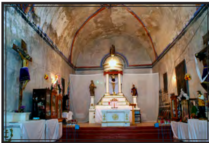
Fig. 111 Vista del interior de la visita de Tepatetipa (foto: Eumelia Hernández)
