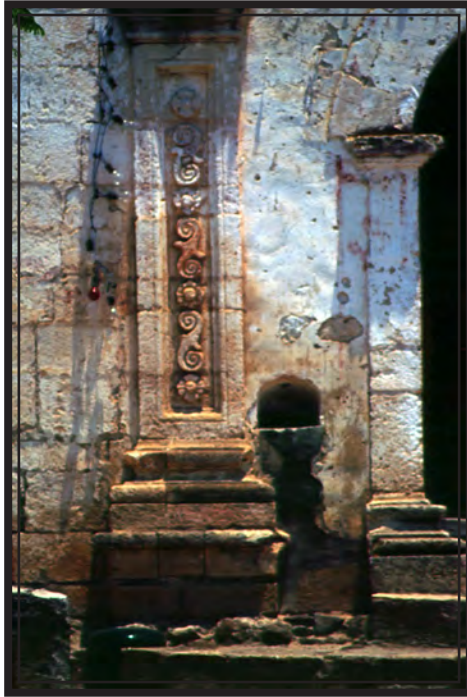
Fig. 106 Jamba e imposta que sostiene el arco del vano principal de la visita de Tepatetipa (foto: Eumelia Hernández)
