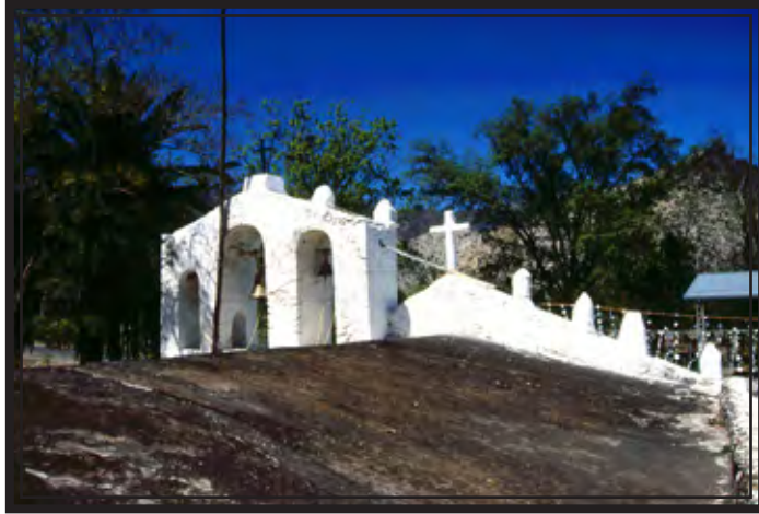
Fig. 144 Vista de la espadaña desde la bóveda la visita Tlatemalco (foto: Eumelia Hernández)
