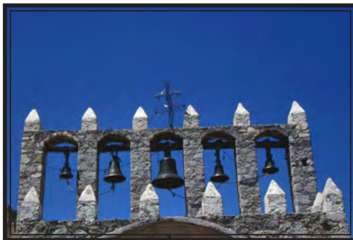
Fig. 24 Espadaña de la visita de Atzolcintla (foto: Eumelia Hernández)
