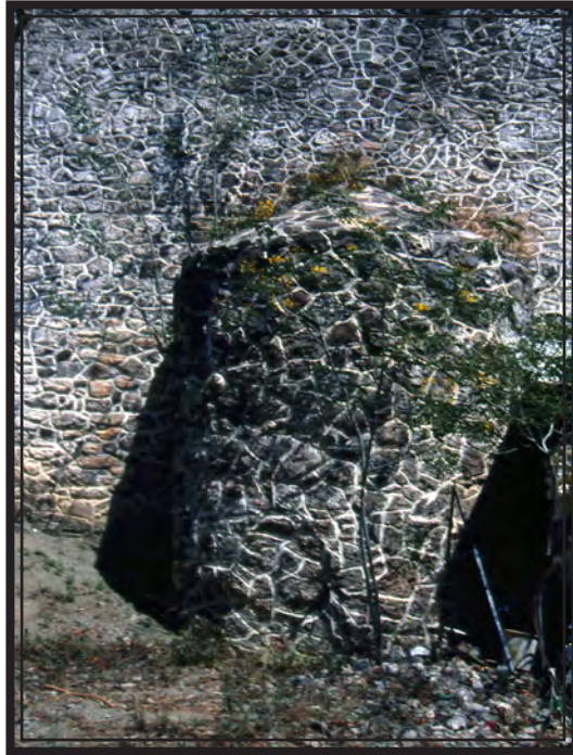
Fig. 33 Contrafuerte de forma atípica de la visita de Hualula (foto: Eumelia Hernández)
