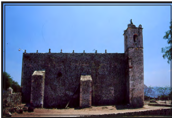
Fig. 97 Vista lateral norte en donde se observa los contrafuertes irregulares de la visita de Tepatetipa (foto: Eumelia Hernández)
