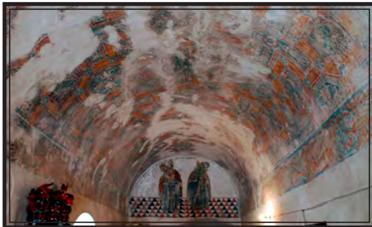
Fig. 114 Bóveda de la sacristía de la visita de Tepatetipa (foto: Eumelia Hernández)
