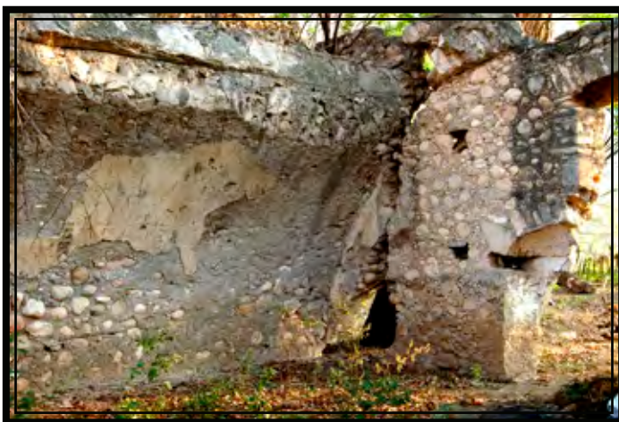
Fig. 87 Arranque de la bóveda de la visita de San Juan (foto: Eumelia Hernández)
