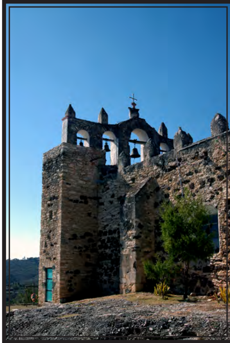
Fig. 165 Vista lateral poniente, donde se aprecia el contrafuerte que da acceso al coro y a la parte superior de la visita de Tlaxco (foto: Eumelia Hernández)
