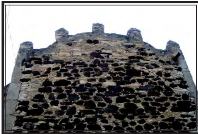
Fig. 163 Momentos constructivos de la visita de Tlaxco (foto: María Eugenia Campos Gallegos)
