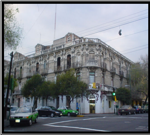
FOTOGRAFIA QUE MUESTRA EL ESTADO ACTUAL DEL EDIFICIO
