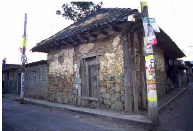
Viviendas como la de arriba en camino a Cobá, Quintana Roo, o la de abajo en Michoacán, con frecuencia son abandonadas porque ocupantes optan por casas contemporáneas. (LS)
