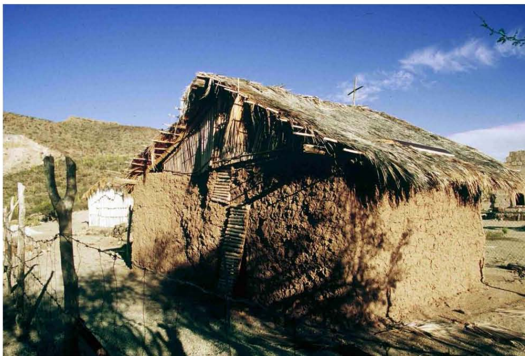
Casa de terrado con más de cien años de antigüedad en Santa Gertrudis, Baja California, en 1995. Dos años más tarde fue destruida por los constructores de la carretera que llegó al lugar con el único motivo de que "estaba vieja". (LS)
