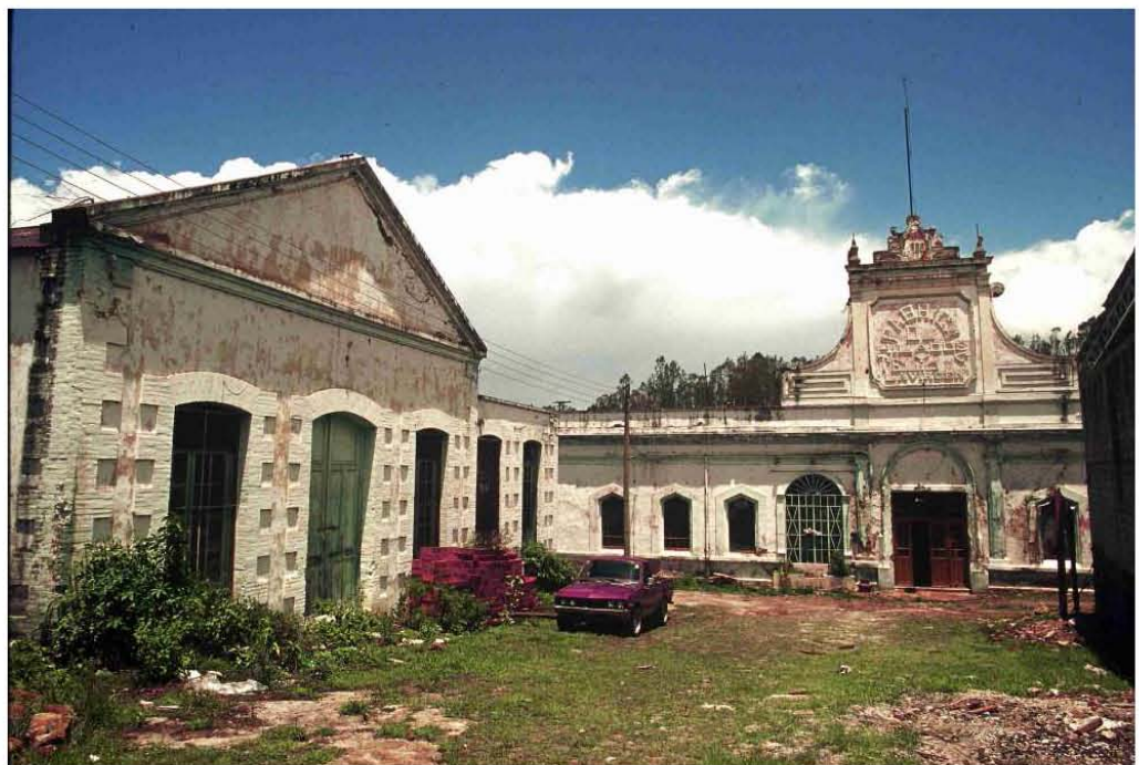
La arquitectura industrial del siglo XIX combina elementos tanto del academicismo como de lo tradicional, como la Fábrica de Hilados La Virgen, en Ciudad Hidalgo, Michoacán, hoy abandonada y parcialmente destruida. (LS)
