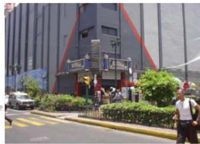
Esquina calle Génova y calle Liverpool
